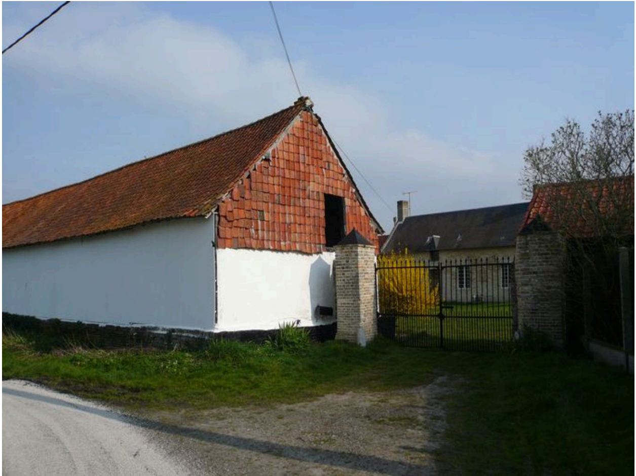
Vue de l'entrée depuis la rue.
