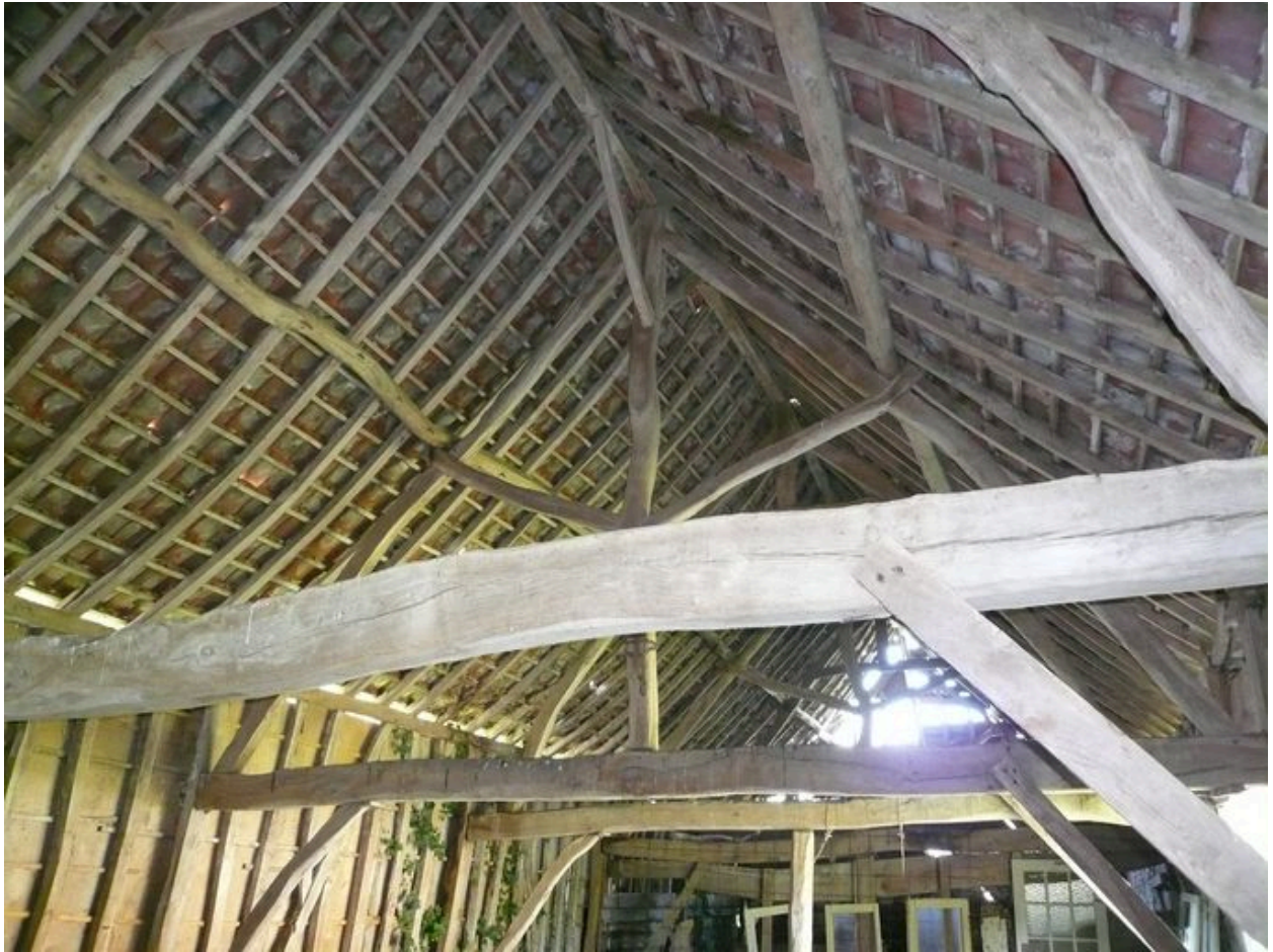
Vue de la charpente.
