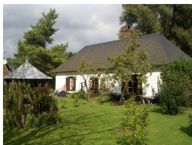
Vue générale. Phot. Inès Guérin IVR22_20078005111NUCA
