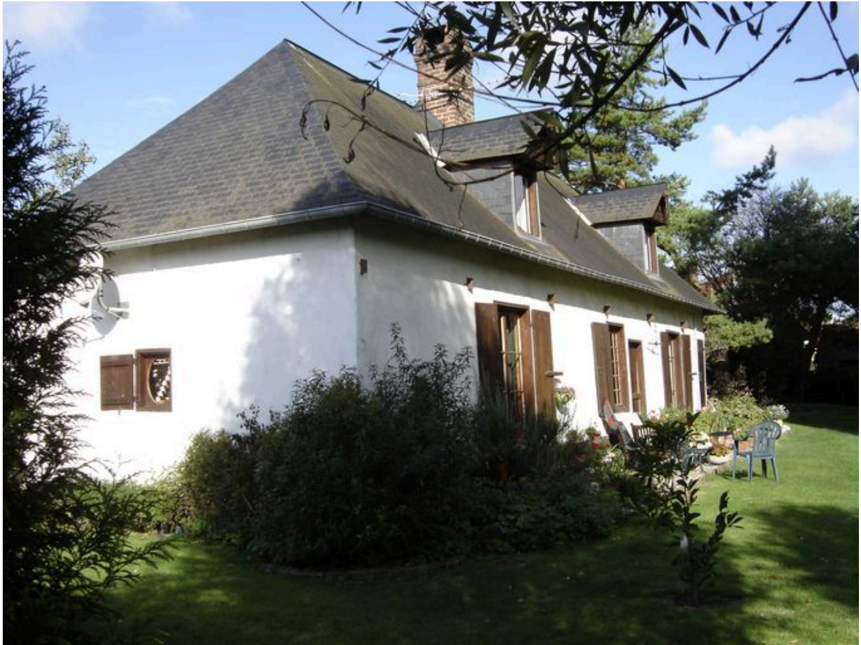
Vue postérieure du logis.
