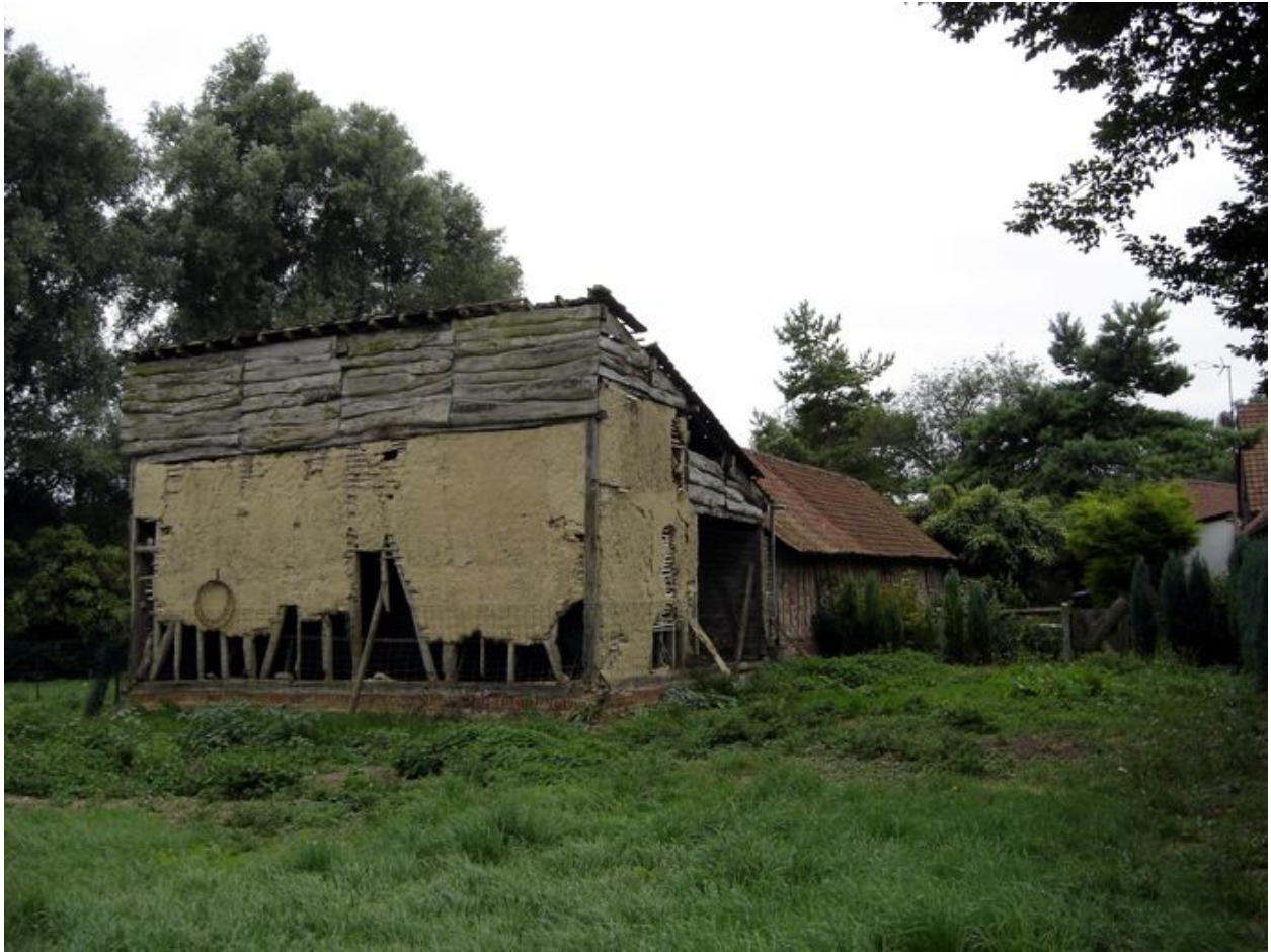
Vue postérieure des dépendances.
