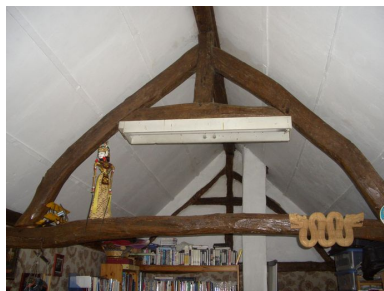
Vue de la charpente de l'annexe. Phot. Inès Guérin IVR22_20078005125NUCA
