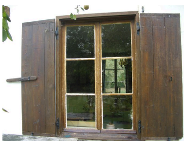
Vue détaillée du système de contrevent à tourniquet. Phot. Inès Guérin IVR22_20078005119NUCA
