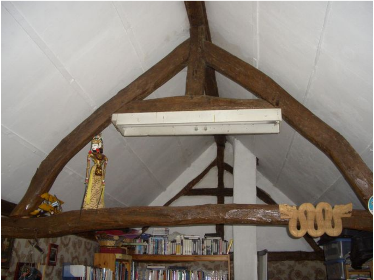
Vue de la charpente de l'annexe.
