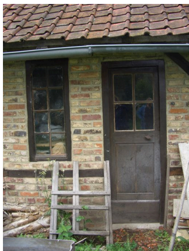
Vue détaillée des huisseries. Phot. Inès Guérin IVR22_20078005115NUCA
