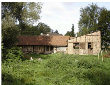
Vue latérale des dépendances. Phot. Inès Guérin IVR22_20078005114NUCA
