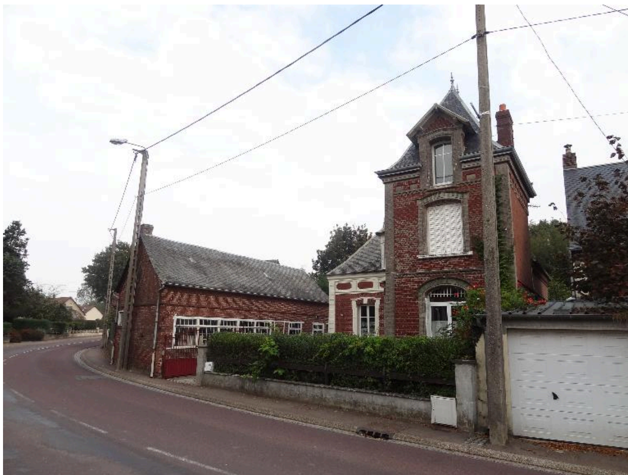
Vue générale, depuis la rue d'Ault.
