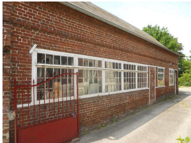
Vue de l'ancienne fabrique de cadenas. Phot. Frédéric-Nicolas Kocourek IVR22_20158005066NUCA
