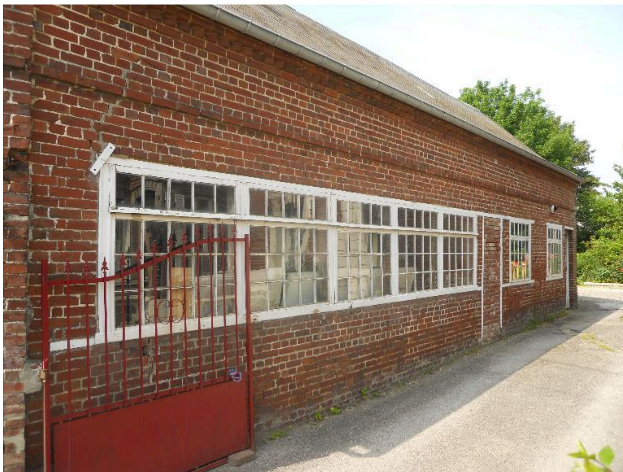
Vue de l'ancienne fabrique de cadenas.
