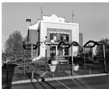
Élévation antérieure. Phot. Thierry Petitberghien IVR31_20025900352X
