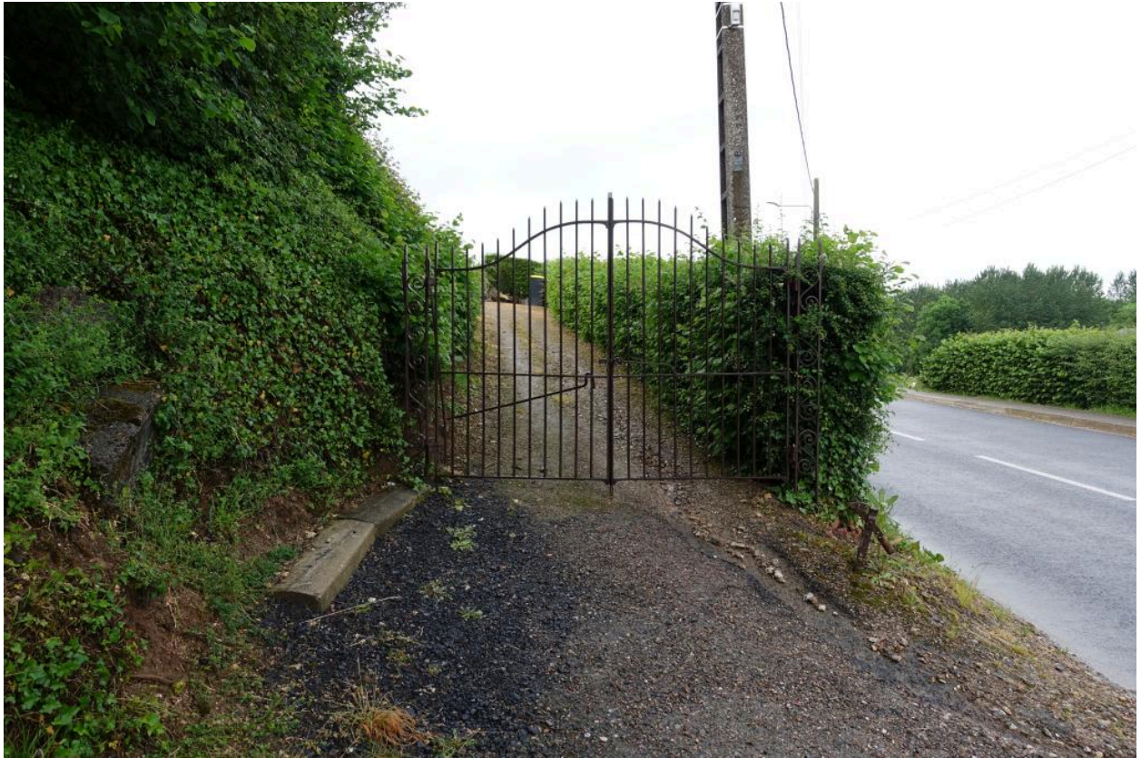
Entrée du cimetière, vue depuis le nord-est.
