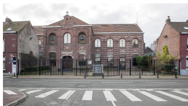
Élévation antérieure de la chapelle Phot. Pierre Thibaut IVR31_20155902069NUCA
