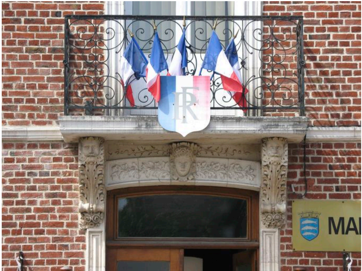
Détail du balcon de la façade principale et de ses consoles sculptées.
