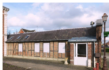
Vue générale des anciennes dépendances attenantes.
