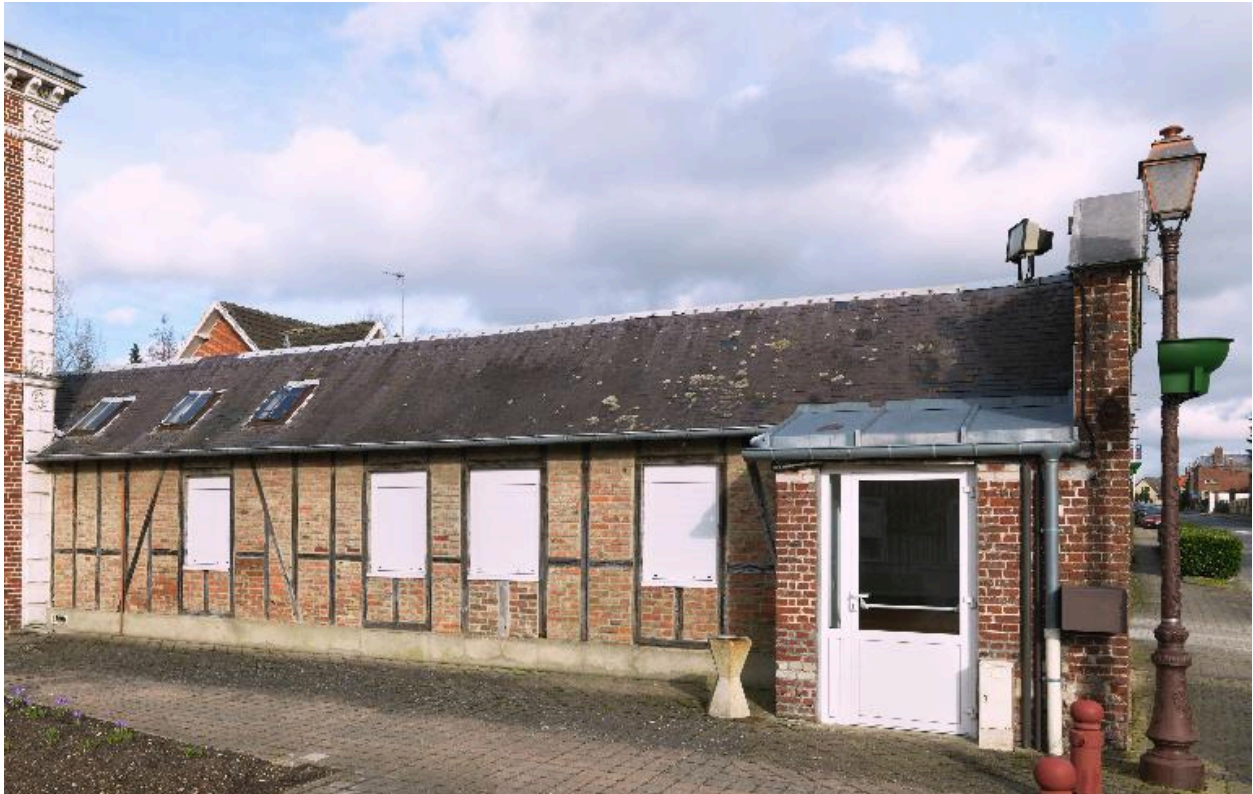
Vue générale des anciennes dépendances attenantes.
