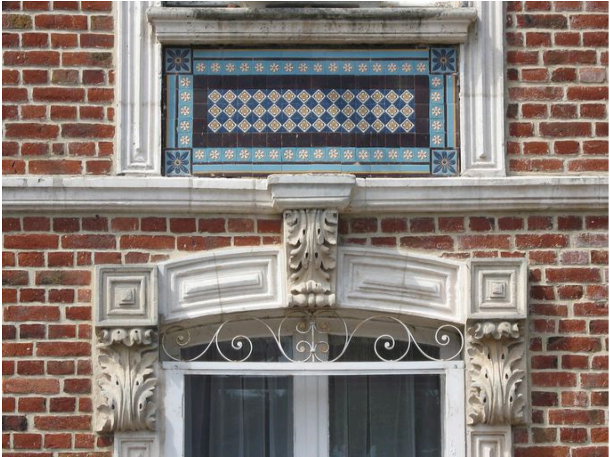
Détail des impostes de fenêtre du premier étage et linteau mouluré de la baie du rez-de-chaussée.
