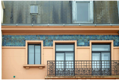
Détail du décor de terre vernissée de la frise sous la corniche. Phot. Thibaut Pierre (reproduction) IVR32_20216200589NUCA
