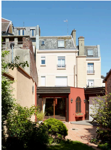
Vue de l'arrière depuis le jardin. Phot. Delphine Volto-Jourdan IVR32_20216200638NUCA
