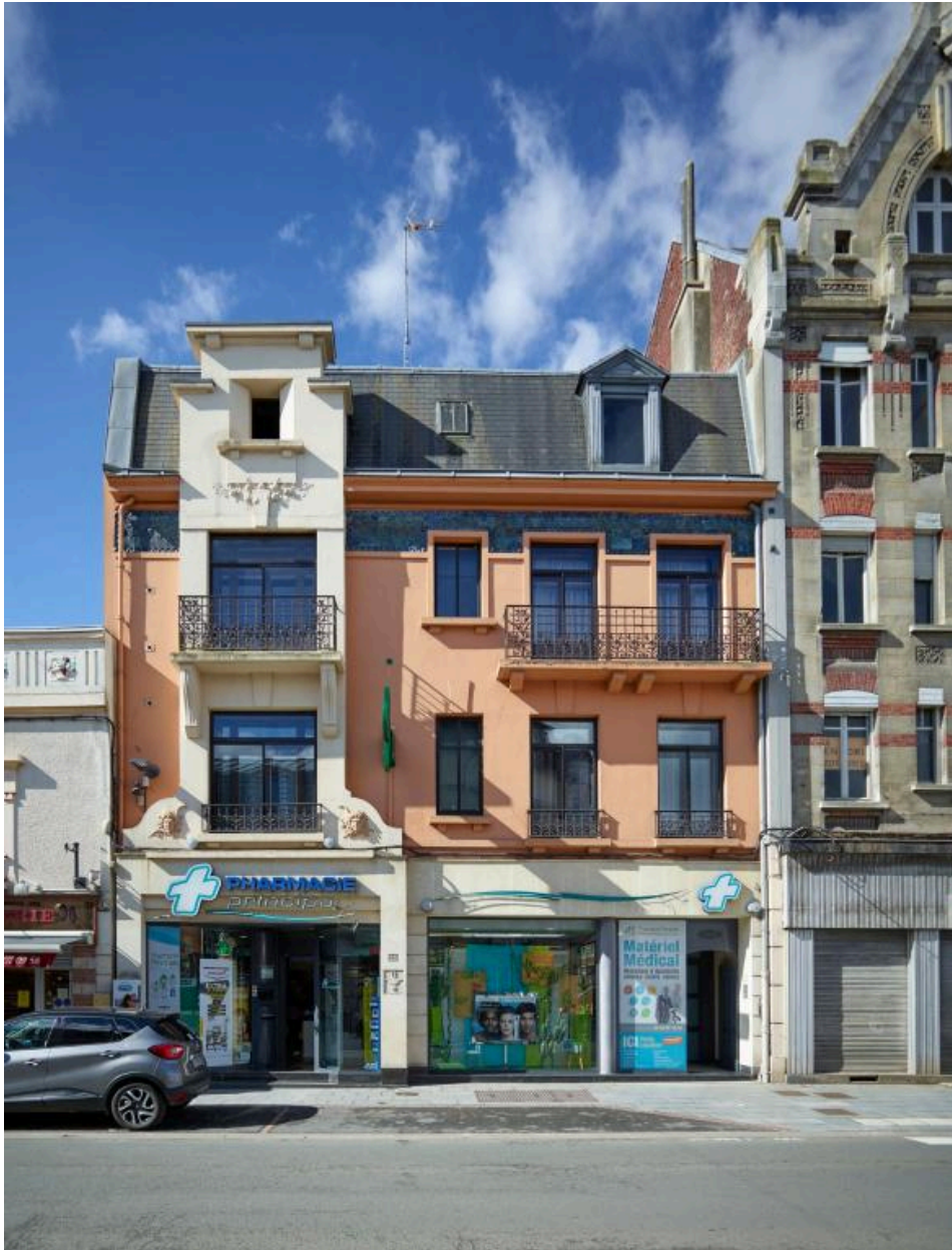
Vue générale depuis la rue de Péronne.
