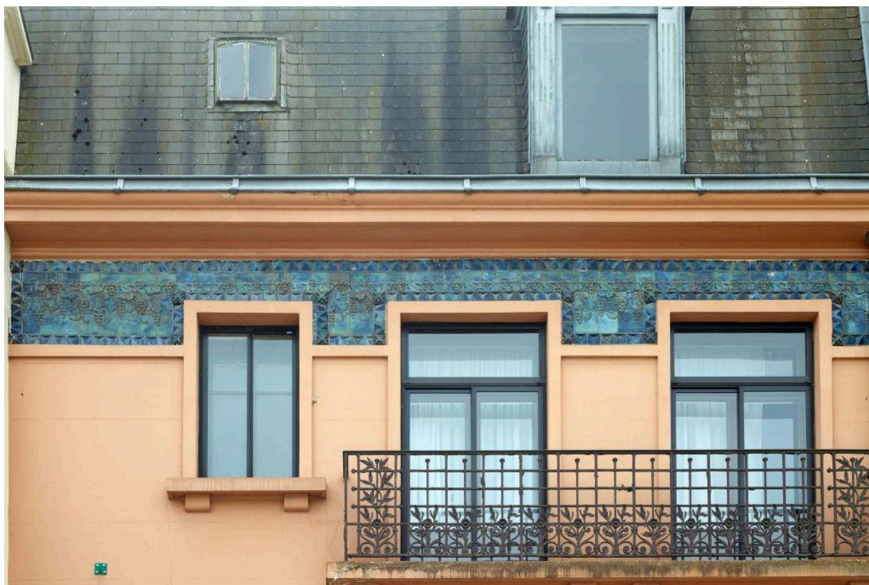
Détail du décor de terre vernissée de la frise sous la corniche.
