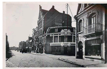
Rue de Péronne. Carte postale, vers 1930 (coll. part.). La pharmacie Carbonnelle est la quatrième maison à droite. Phot. Thibaut Pierre (reproduction) IVR32_20206200033NUCA
