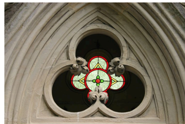
Détail du vitrail quadrilobé. Phot. Caroline Vincent IVR22_20098001437NUCA
