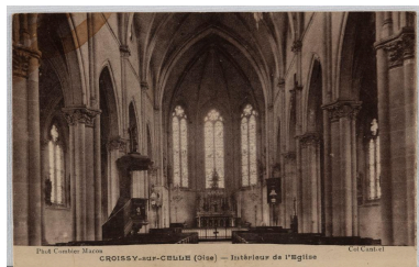
Croissy-sur-Celle (Oise). Intérieur de l'église, carte postale, coll. Combier Macon, [1er quart du 20e siècle] (coll. part.). Phot. Marc Kérignard IVR32_20226000099NUCA
