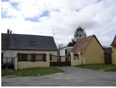
Vue générale. Phot. Inès Guérin IVR22_20058005352NUCA
