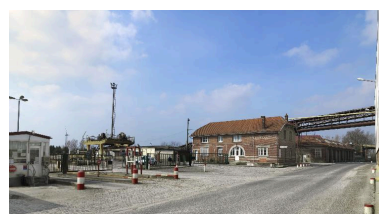
Entrée de la sucrerie et son bureau de pesée, vue depuis la rue. Phot. Thierry Lefebure IVR22_20158000235NUC2A
