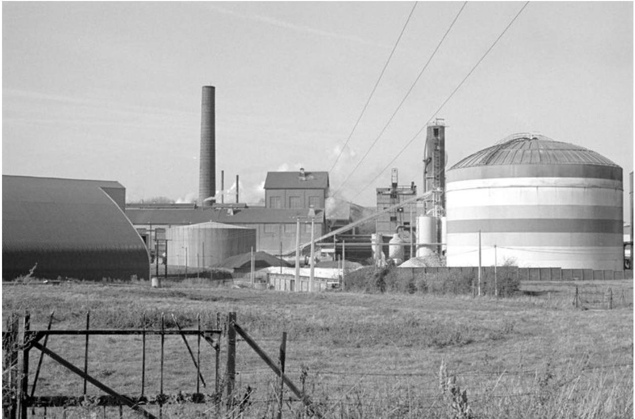
Réservoirs industriels, four à chaux, magasin industriel, vue partielle flanc est
