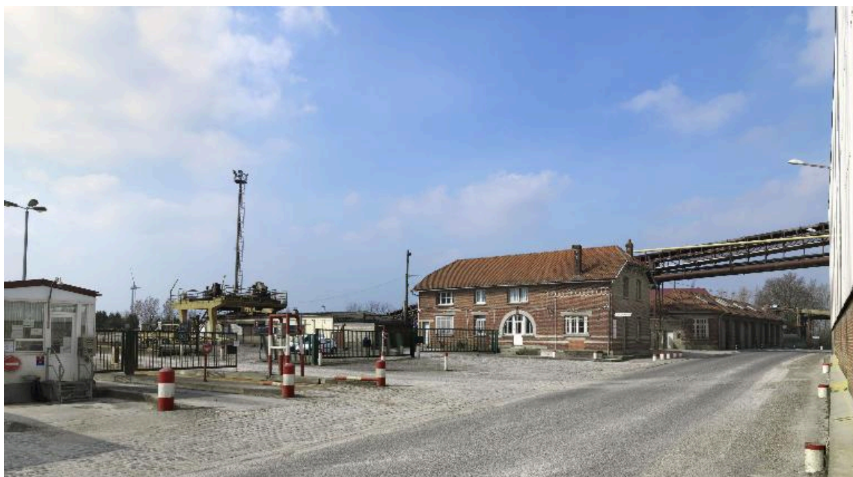
Entrée de la sucrierie et son bureau de pesée, vue depuis la rue.
