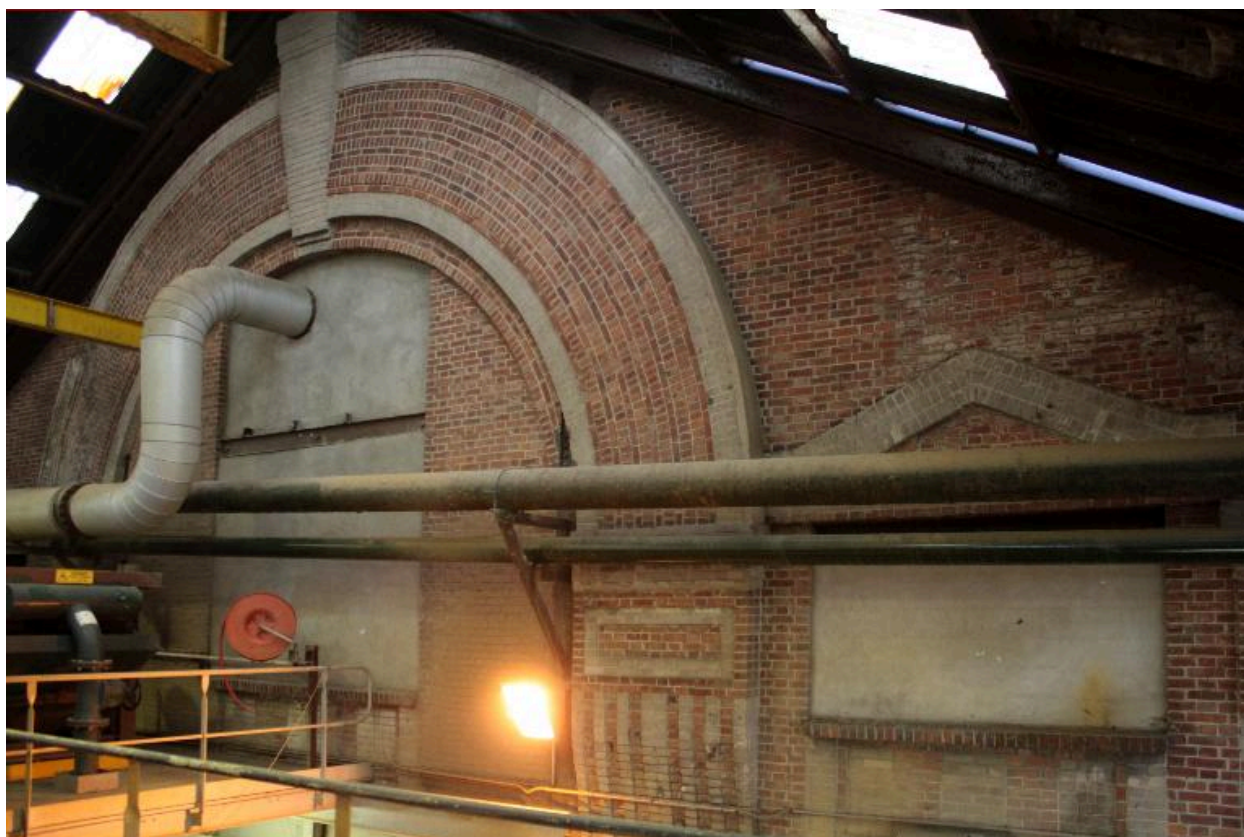
Ancien pignon extérieur de la sucrierie, aujourd'hui intégré dans les nouveaux ateliers.
