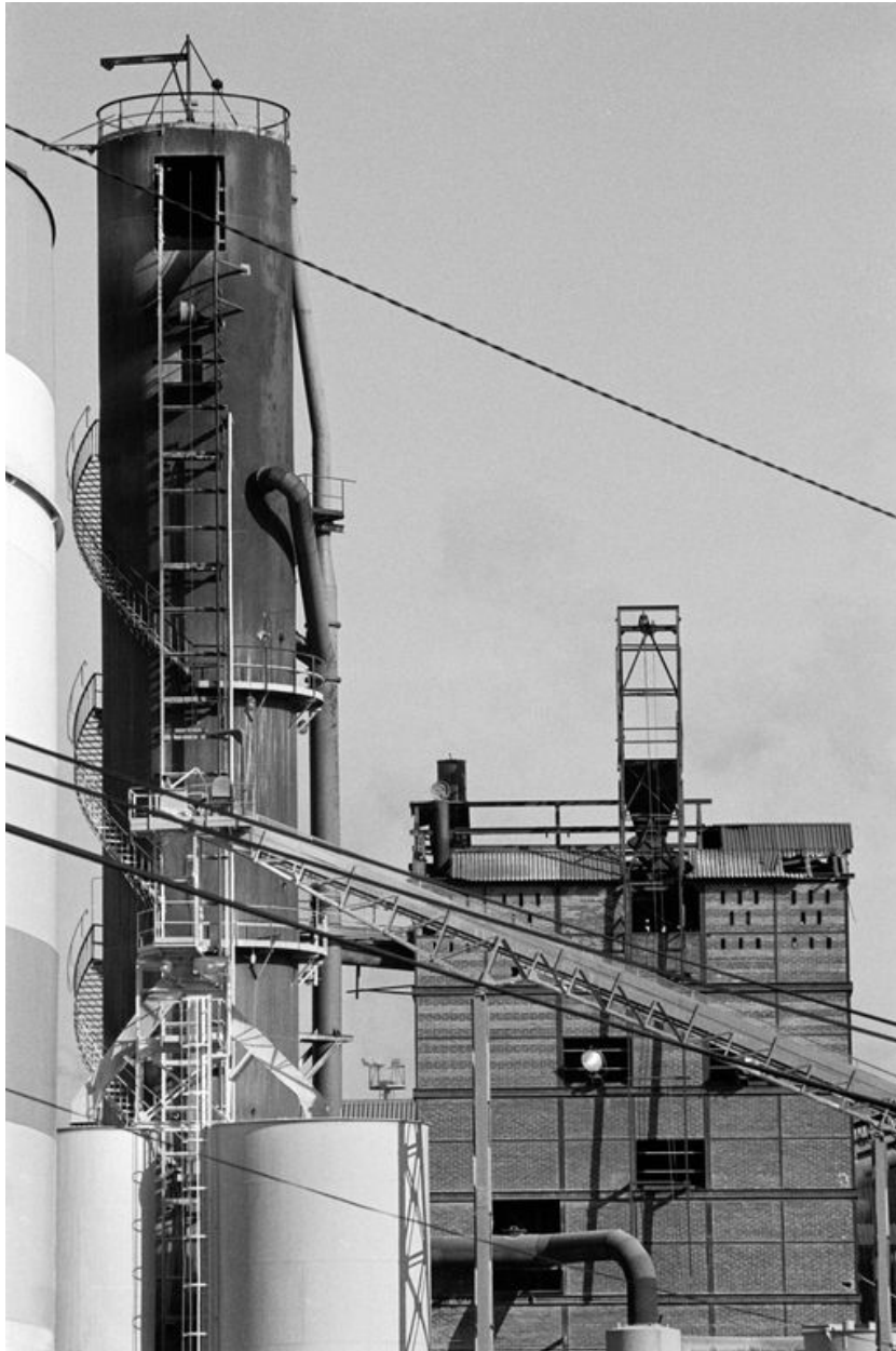
Four à chaux et atelier de fabrication, détail, flanc est.
