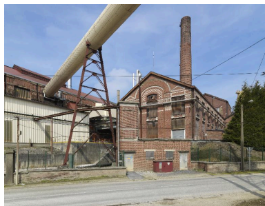
Vue d'ensemble sud-ouest de l'atelier de fabrication principal de la sucrerie. Phot. Thierry Lefébure IVR22_20158000230NUC2A
