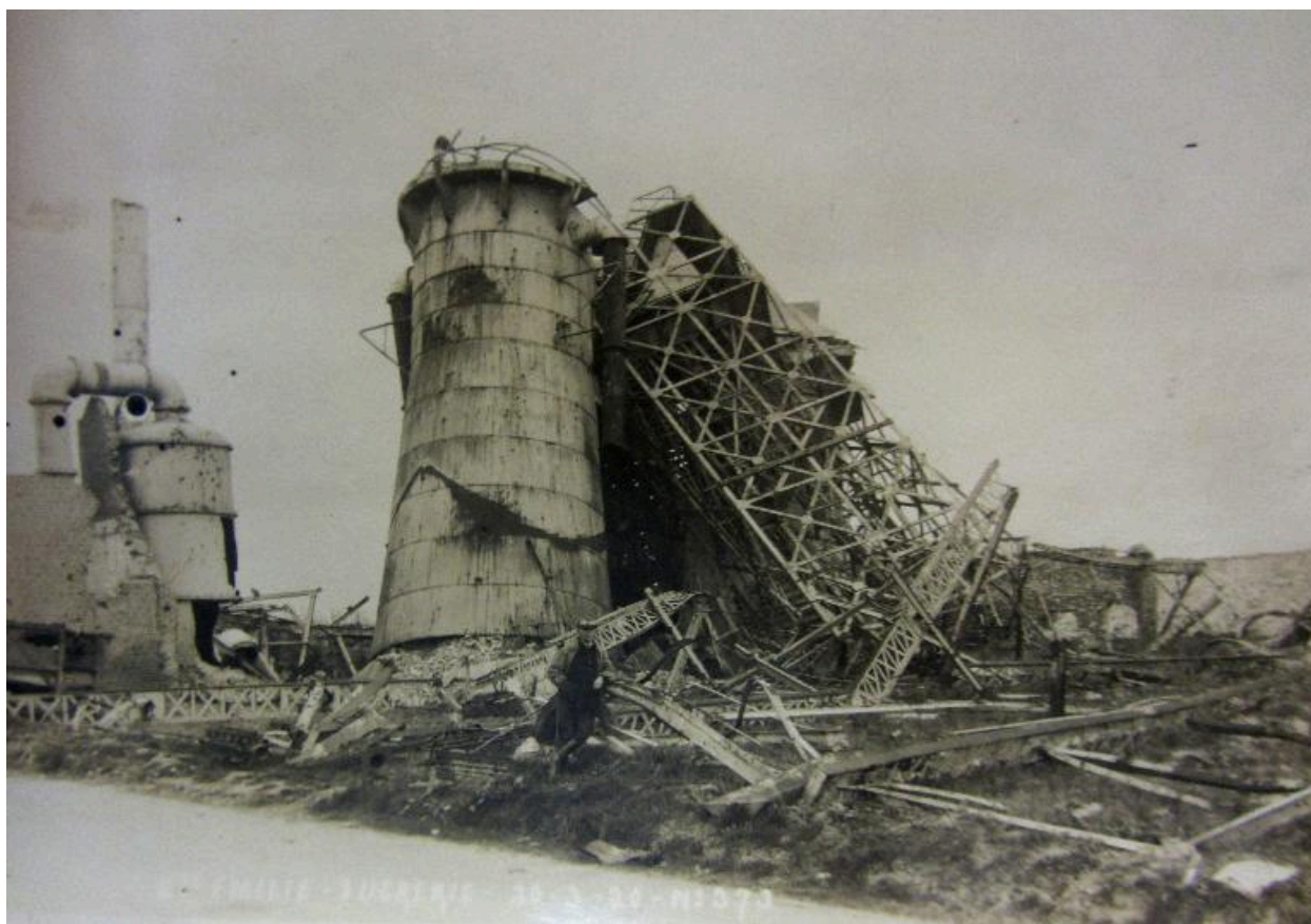
Vestiges du four à chaux de l'ancienne sucrierie de Sainte-Emilie, 30 mars 1920 (AD Somme ; 10 R 79).
