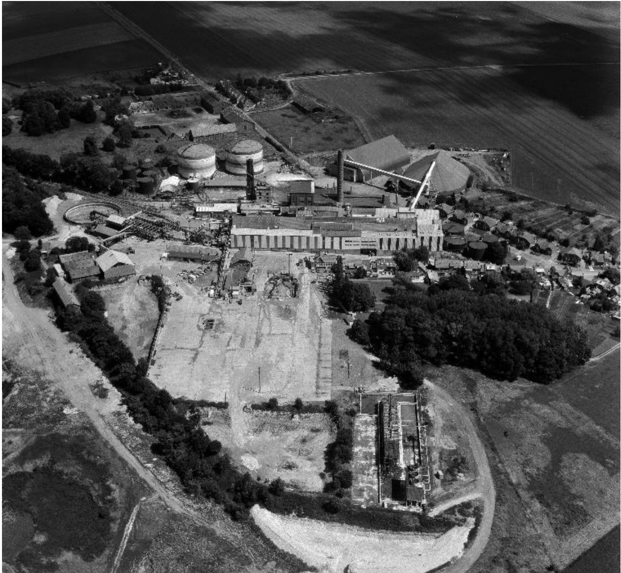
Vue aérienne, flanc ouest.
