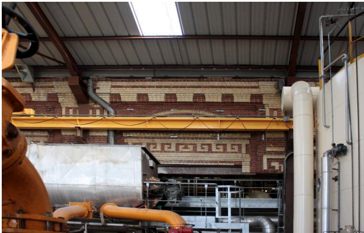
Vue partielle de l'ornementation en brique de l'ancien atelier de fabrication de la sucrerie.
