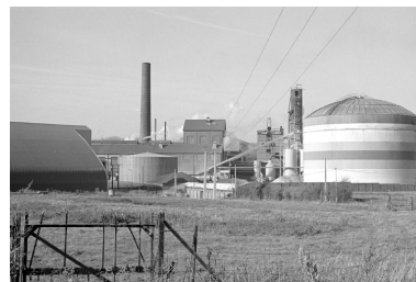
Réservoirs industriels, four à chaux, magasin industriel, vue partielle flanc est Phot. Francis Dubuc IVR22_19908001277Z
