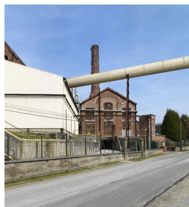
Pignon sud de l'atelier principal de fabrication de la sucrierie Phot. Thierry Lefébure IVR22_20158000228NUC2A
