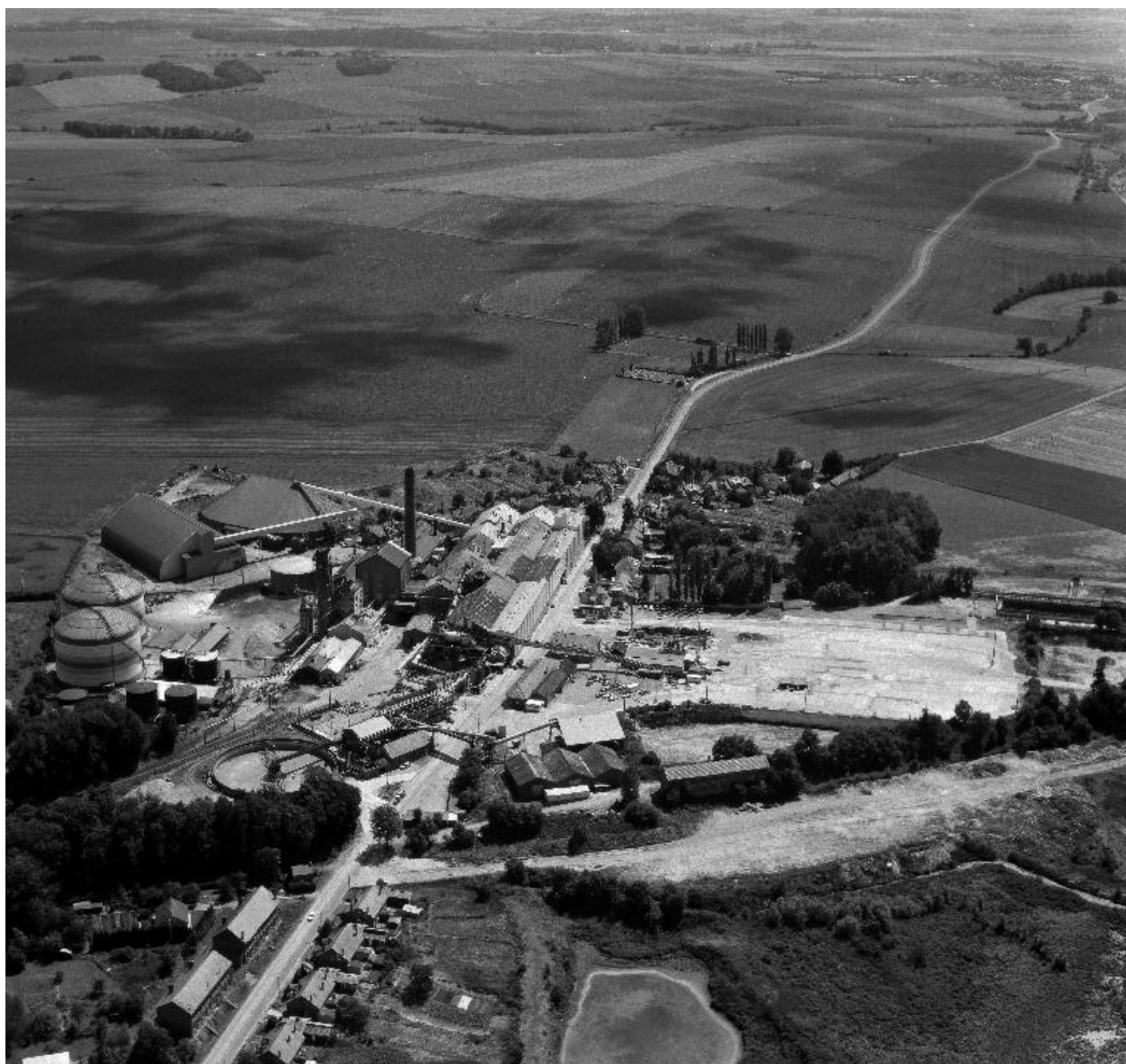
Vue aérienne, flanc nord.
