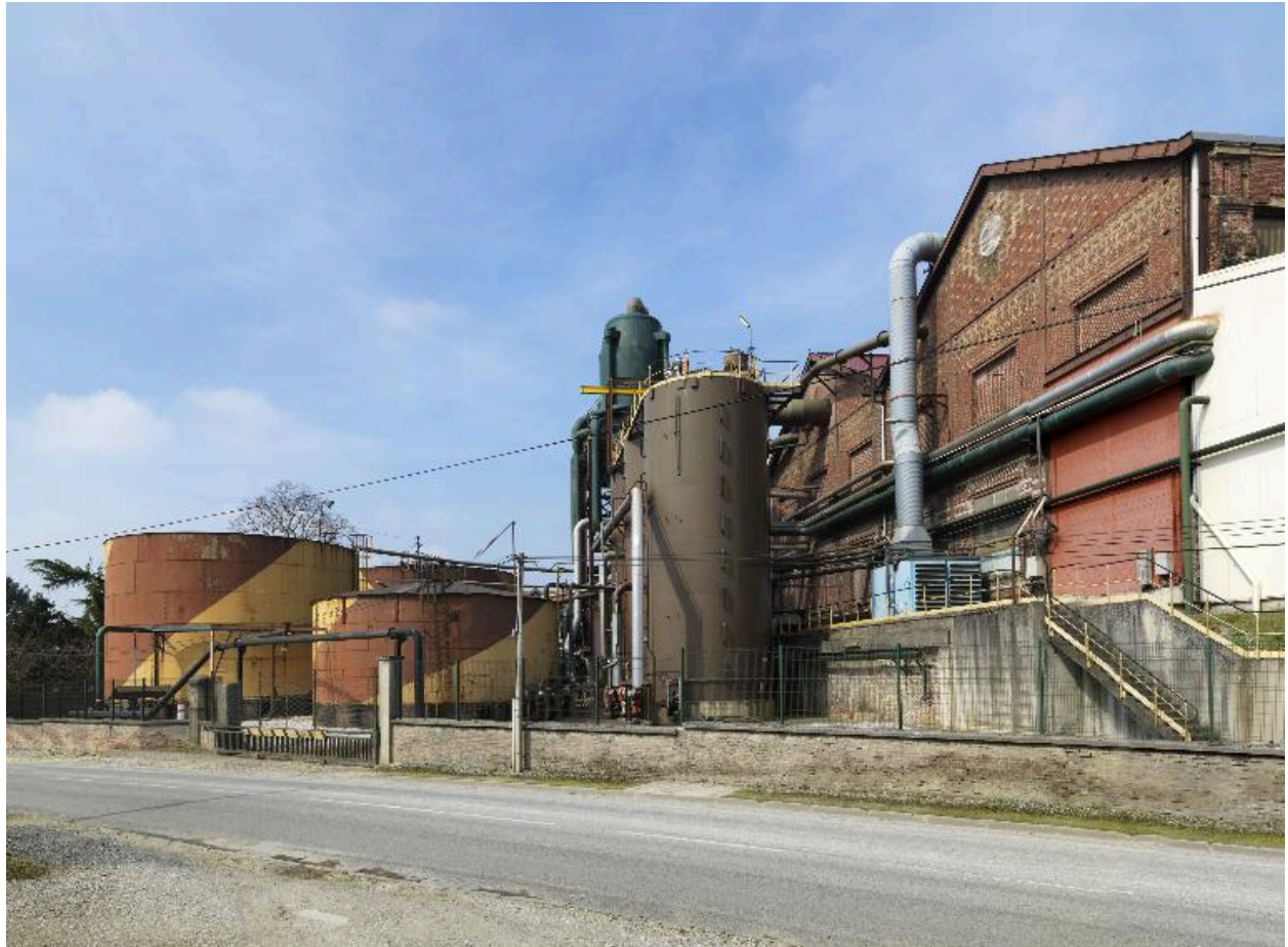
Pignons de l'atelier principal de la sucrierie.
