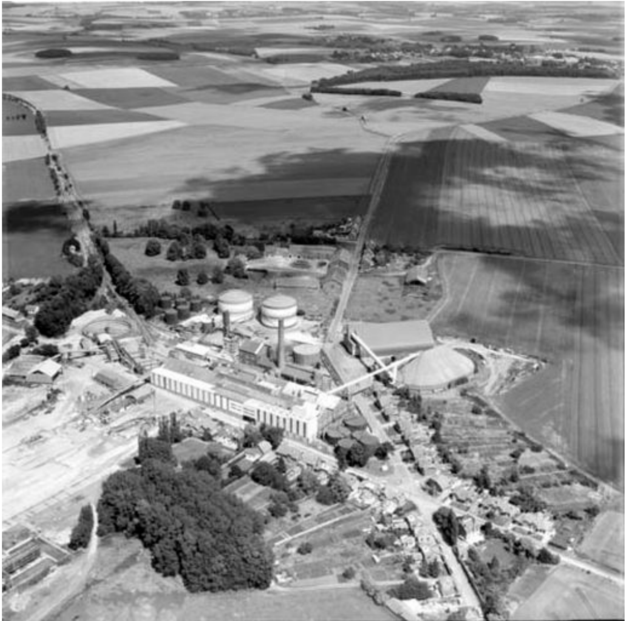
Vue aérienne, flanc sud-ouest.
