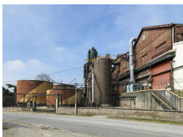
Pignons de l'atelier principal de la sucrierie. Phot. Thierry Lefébure IVR22_20158000229NUC2A
