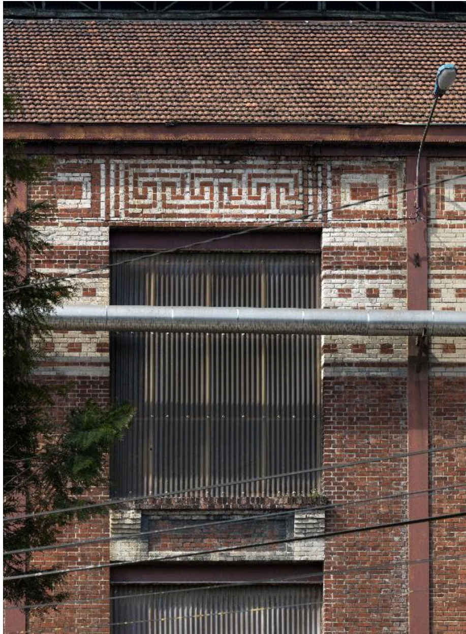
Détail de l'ornementation d'une baie de l'atelier principal de fabrication.
