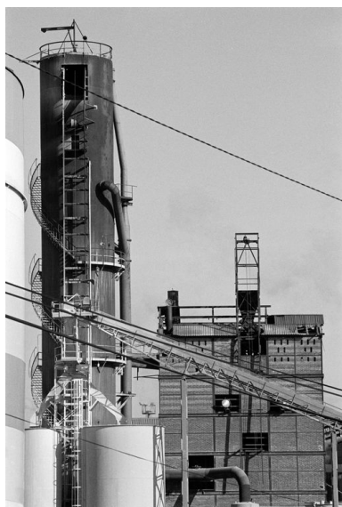
Four à chaux et atelier de fabrication, détail, flanc est. Phot. Francis Dubuc IVR22_19908001273Z
