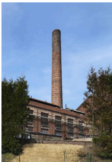
Vue de la façade longitudinale ouest de l'atelier principal de fabrication. Phot. Thierry Lefébure IVR22_20158000232NUC2A
