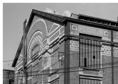
Atelier de fabrication, détail. Phot. Francis Dubuc IVR22_19908001263Z
