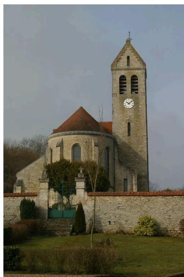
Vue générale depuis le chevet de l'église. Phot. Irwin Leullier IVR22_20050200640NUCA
