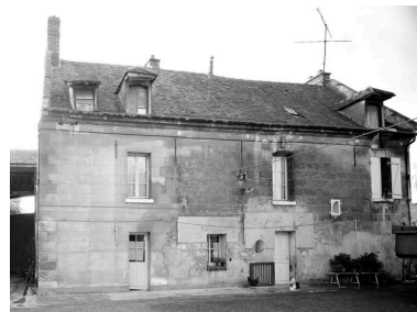
Elévation postérieure. Phot. Fabrice Charrondière IVR22_19856001403V
