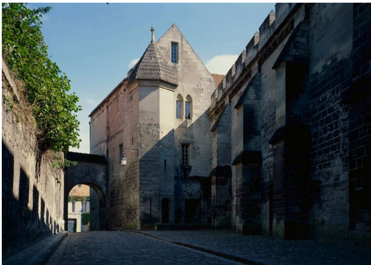
Rue Corbault, le mur nord du cloître et l'officialité.
