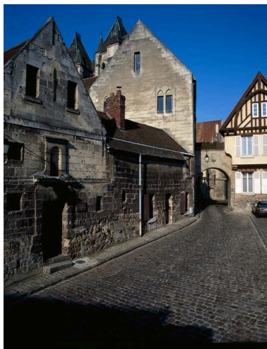
Place Corbault. Les pignons de la bibliothèque et de l'officialité. Phot. Thierry Lefébure IVR22_19976000231XA
