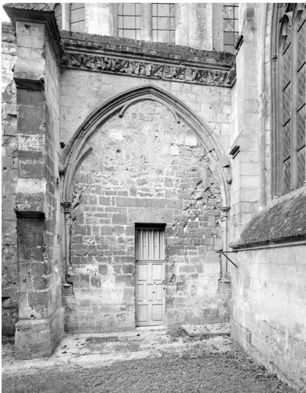
Le cloître. Elévation extérieure de la seule travée conservée de la galerie est.
