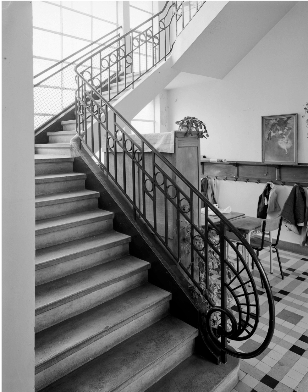
Hall d'entrée : la rampe d'escalier.
