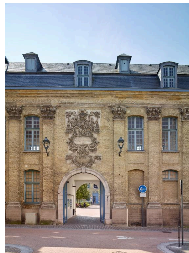
Bâtiment est qui s'élève le long de la rue du Saint-Sépulcre, élévation de la façade sur rue, détail de l'entrée de l'ancien hôpital général.
