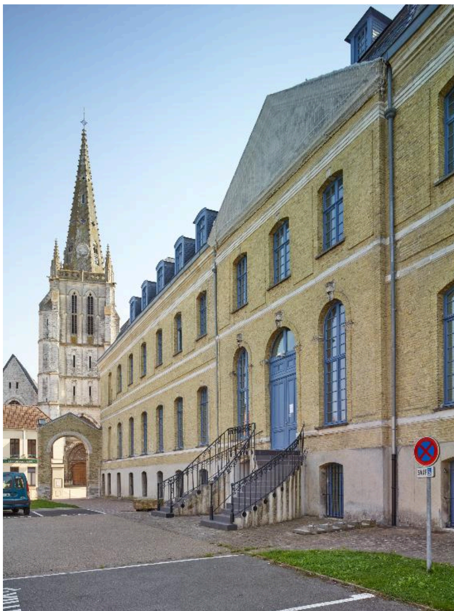
Bâtiment nord, élévation de la façade nord donnant sur le jardin, vue générale prise de trois-quarts droit.
