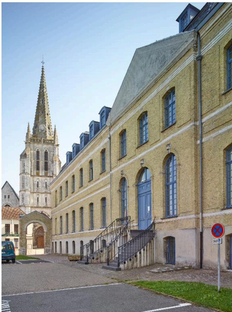
Bâtiment nord, élévation de la façade nord donnant sur le jardin, vue générale prise de trois-quarts droit.
