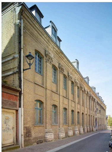
Bâtiment est qui s'élève le long de la rue du Saint-Sépulcre, élévation de la façade sur rue, vue générale prise en enfilade depuis le flanc gauche ou sud.
