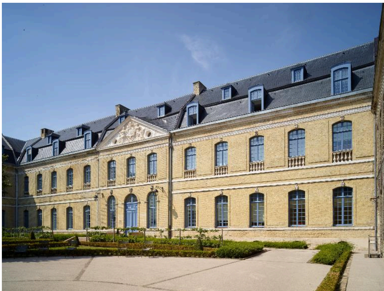
Bâtiment nord, élévation de la façade sud donnant sur la cour d'honneur, vue générale prise de trois-quarts droit.
