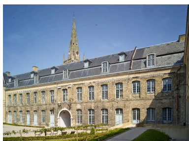
Bâtiment est qui s'élève le long de la rue du Saint-Sépulcre, élévation de la façade sur la cour d'honneur, vue générale prise de trois-quarts droit.
