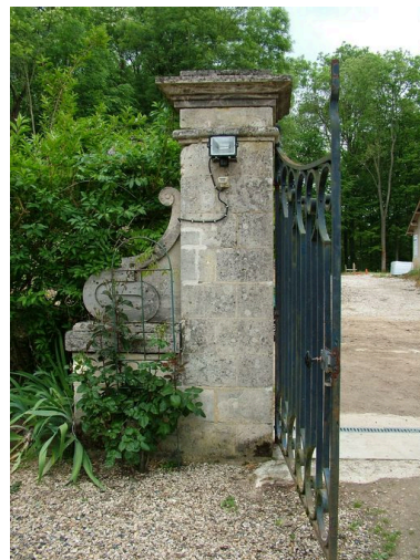
Pilastre du portail d'entrée. Phot. Inès Guérin IVR22_20050200785NUCA
