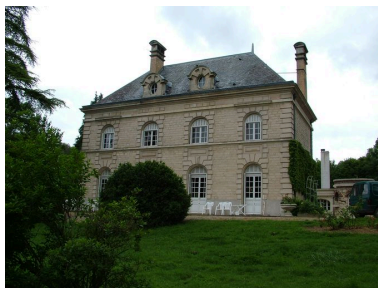
Vue générale. Phot. Inès Guérin IVR22_20050200787NUCA
