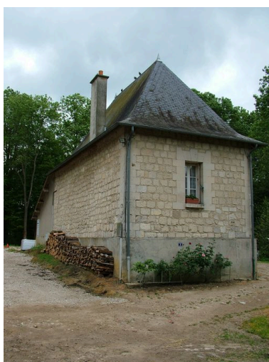
Vue de la maison du gardien. Phot. Inès Guérin IVR22_20050200786NUCA
