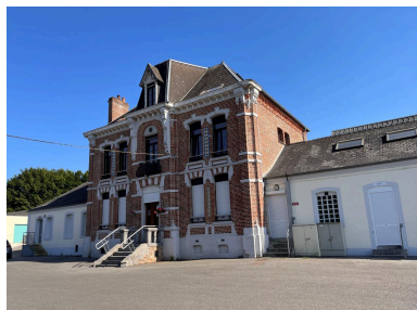
Le logement patronal, vue de trois-quarts. Phot. Bertrand Fournier IVR32_20220205091NUCA
