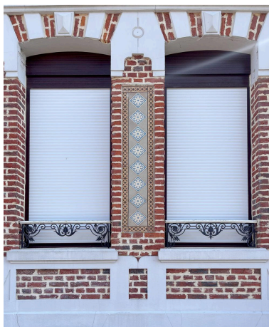
Détail de baies jumelles et du décor de céramique. Phot. Bertrand Fournier IVR22_20220205092NUCA
