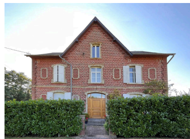
Façade sur rue de la maison de contremaître. Phot. Bertrand Fournier IVR32_20220205093NUCA
