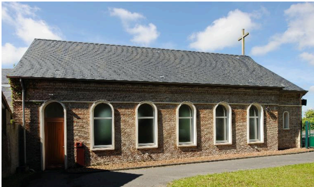
Façade sur cour.
