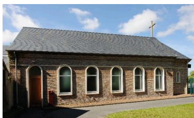
Façade sur cour. Phot. Thierry Lefébure IVR22_20128000326NUC2AQ
