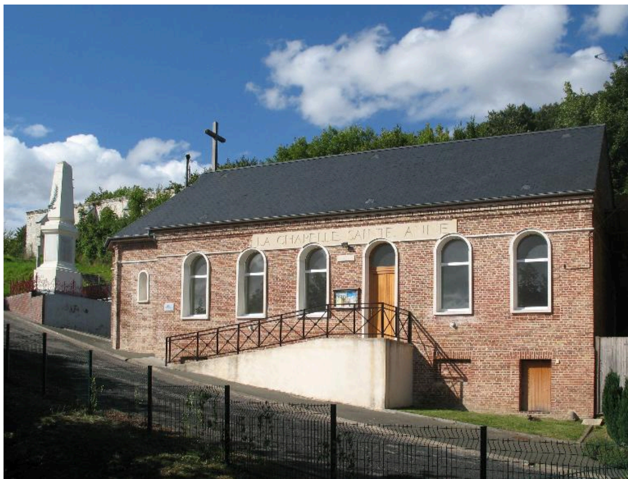
Façade principale sur rue.
