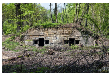
Élévation antérieure Phot. Jean-Marc Ramette IVR31_20146203092NUCA
