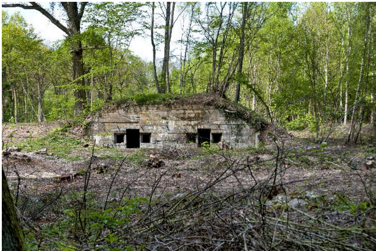
Elévation antérieure, vers le nord-ouest
