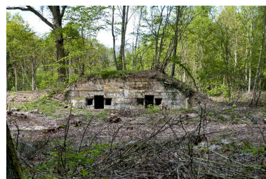
Élévation antérieure, vers le nord-ouest Phot. Jean-Marc Ramette IVR31_20146203095NUCA
