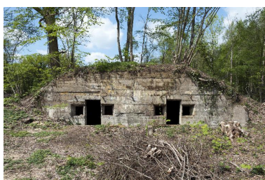
Élévation antérieure Phot. Jean-Marc Ramette IVR31_20146203093NUCA
