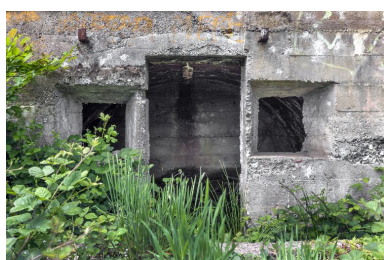
Détail de l'entrée sud-ouest Phot. Jean-Marc Ramette IVR31_20146203098NUCA
