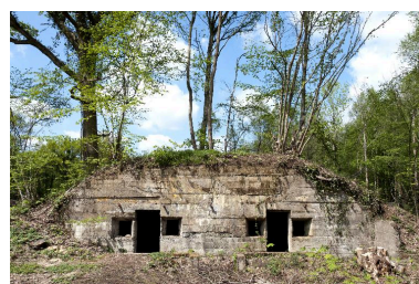
Élévation antérieure Phot. Jean-Marc Ramette IVR31_20146203094NUCA
