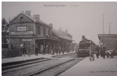
Autre vue de la gare au début du 20e siècle. Phot. Inès Guérin IVR22_20068005064NUCAB
