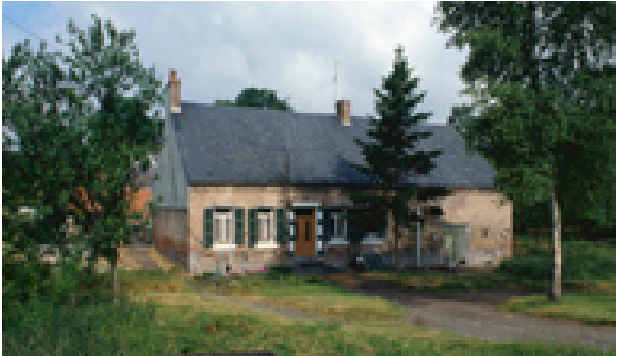
Les bâtiments subsistants (logis, étable), vus depuis l'est.
