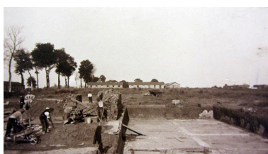
Les fondations du réfectoire et des cuisines de la sucrierie, 22 juillet 1920 (AD Somme ; 49 Fi 30)
