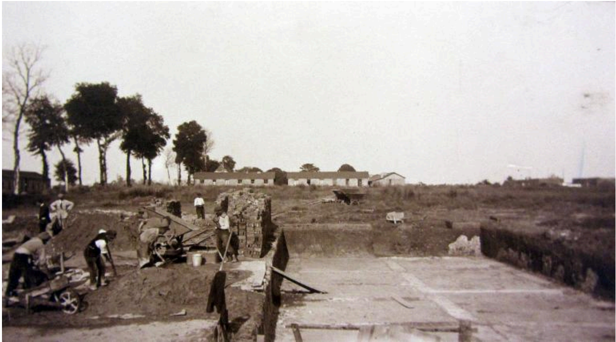
Les fondations du réfectoire et des cuisines de la sucrerie, 22 juillet 1920 (AD Somme ; 49 Fi 30)
