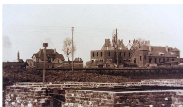
La cantine et la cuisine de la sucrerie, vues depuis les maisons ouvrières, 11 mars 1921 (AD Somme ; 49 Fi 48).
