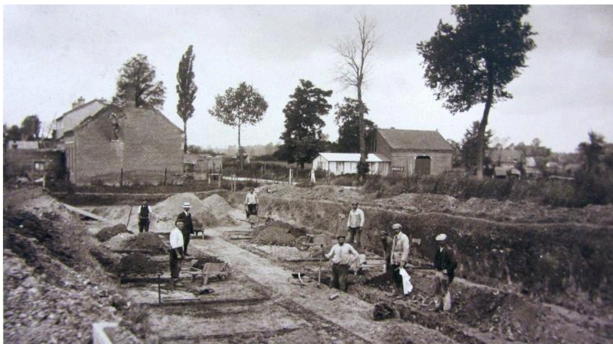
Fondations du bâtiment de réfectoire de la sucrerie, 9 juillet 1920 (AD Somme ; 49 Fi 29).
