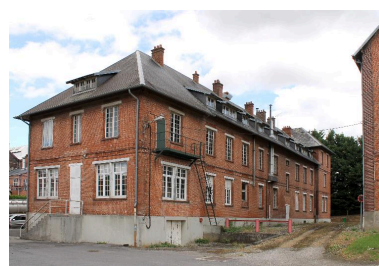
Vue de la façade postérieure, de trois-quarts.
