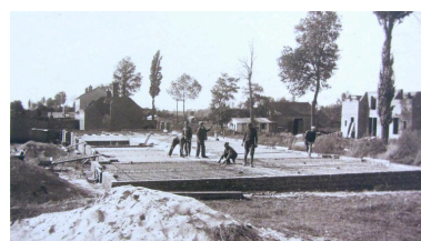
Pose de la dalle en béton armé du bâtiment de réfectoire de la sucrierie, 28 septembre 1920 (AD Somme ; 49 Fi 35).
