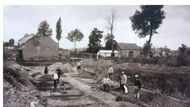
Fondations du bâtiment de réfectoire de la sucrierie, 9 juillet 1920 (AD Somme ; 49 Fi 29).
