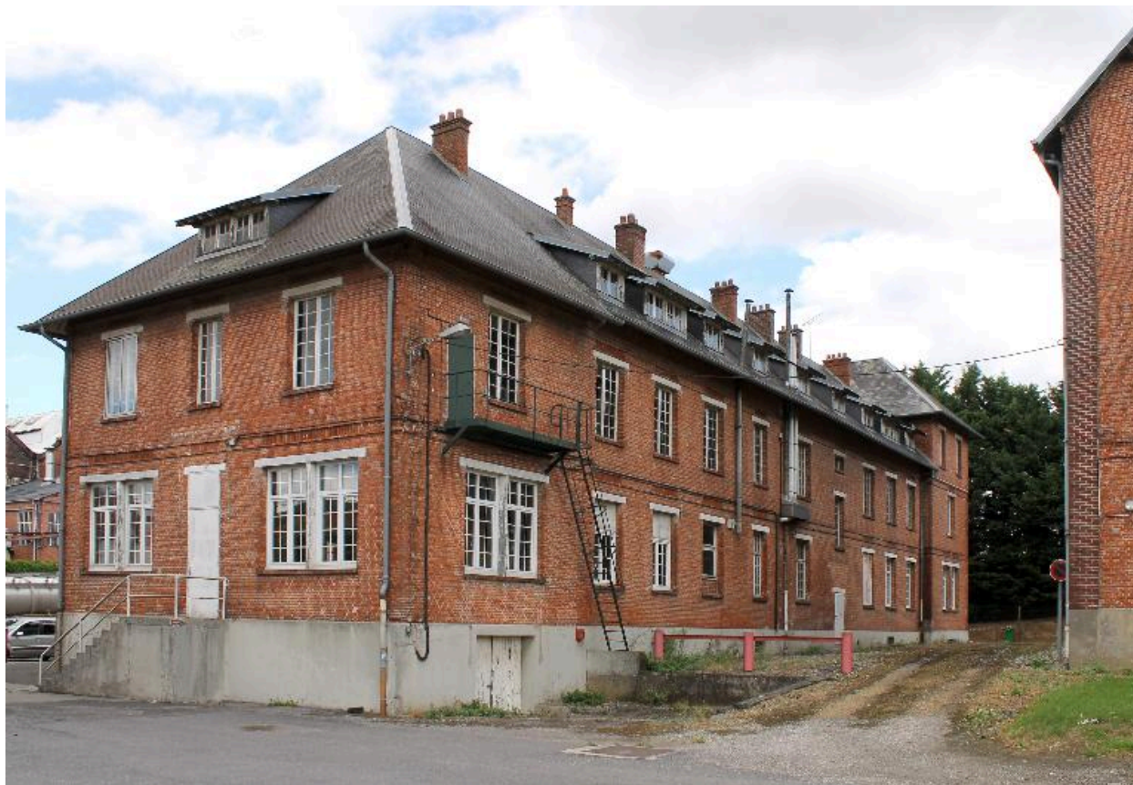
Vue de la façade postérieure, de trois-quarts.
