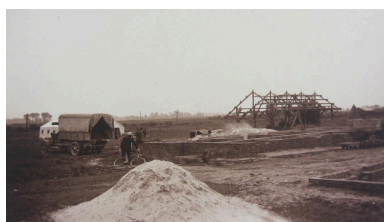
Construction du soubassement du réfectoire de la sucrerie, 11 août 1920 (AD Somme ; 10 Fi 34).
