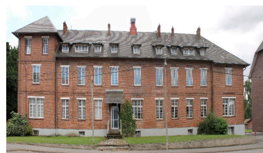
Façade sur rue, vue de face.
