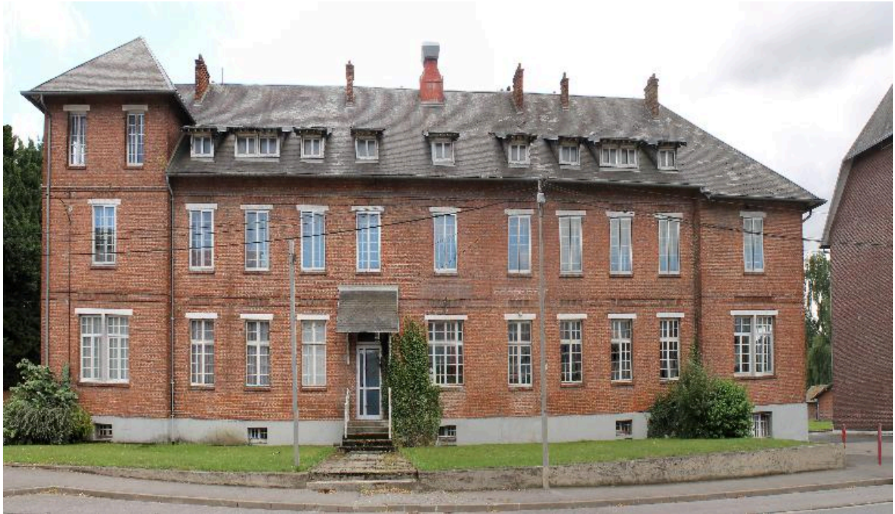
Façade sur rue, vue de face.
