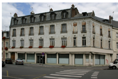
Façade antérieure, rue des Etats-Généraux.
