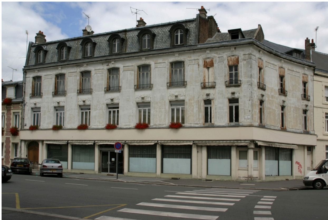
Façade antérieure, rue des Etats-Généraux.
