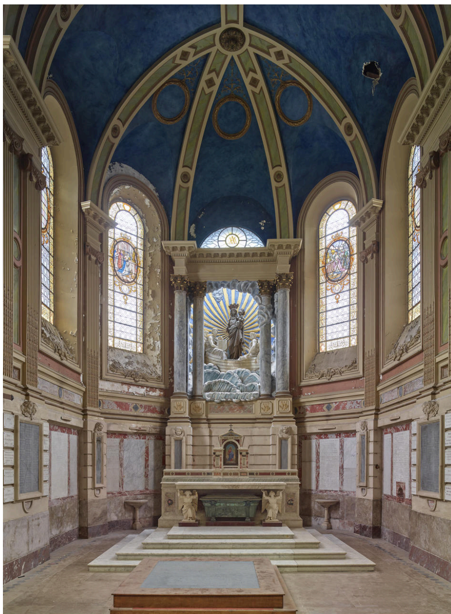
Vue générale de la chapelle restaurée.
