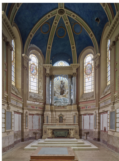
Vue générale de la chapelle restaurée.
