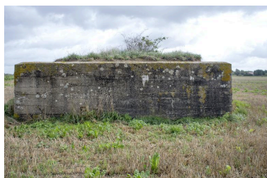
Elévation postérieure, vers le nord-est Phot. Jean-Marc Ramette IVR32_20165901473NUCA
