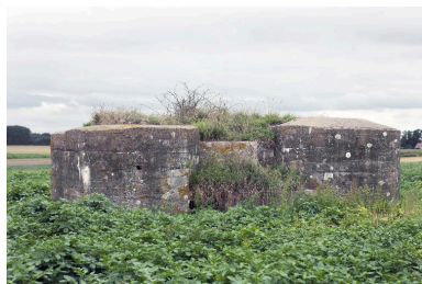
Elévation antérieure, vers l'ouest Phot. Pierre Thibaut IVR31_20155901439NUCA
