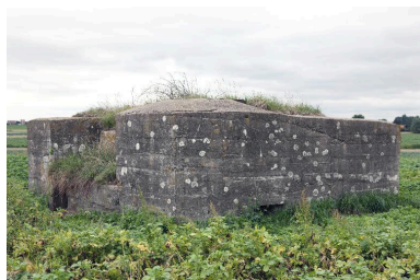
Vue de 3/a, vers le sud Phot. Pierre Thibaut IVR31_20155901441NUCA
