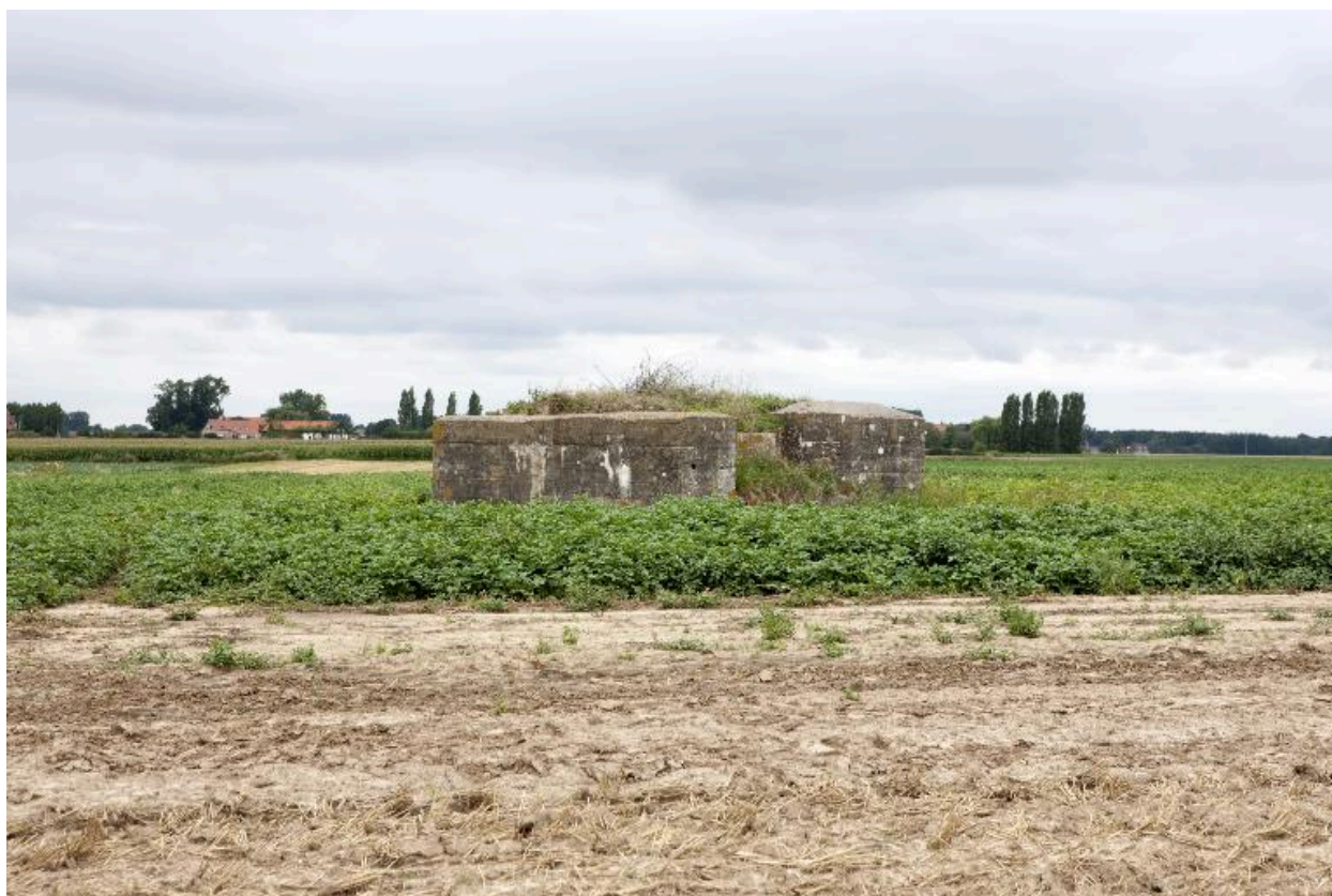
Vue générale vers le nord-ouest
