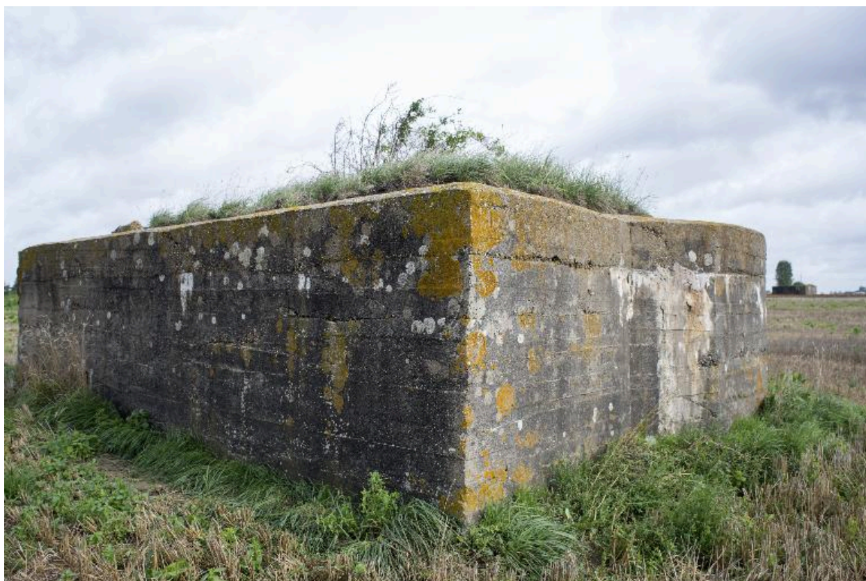
Vue de trois-quarts arrière, vers le nord
