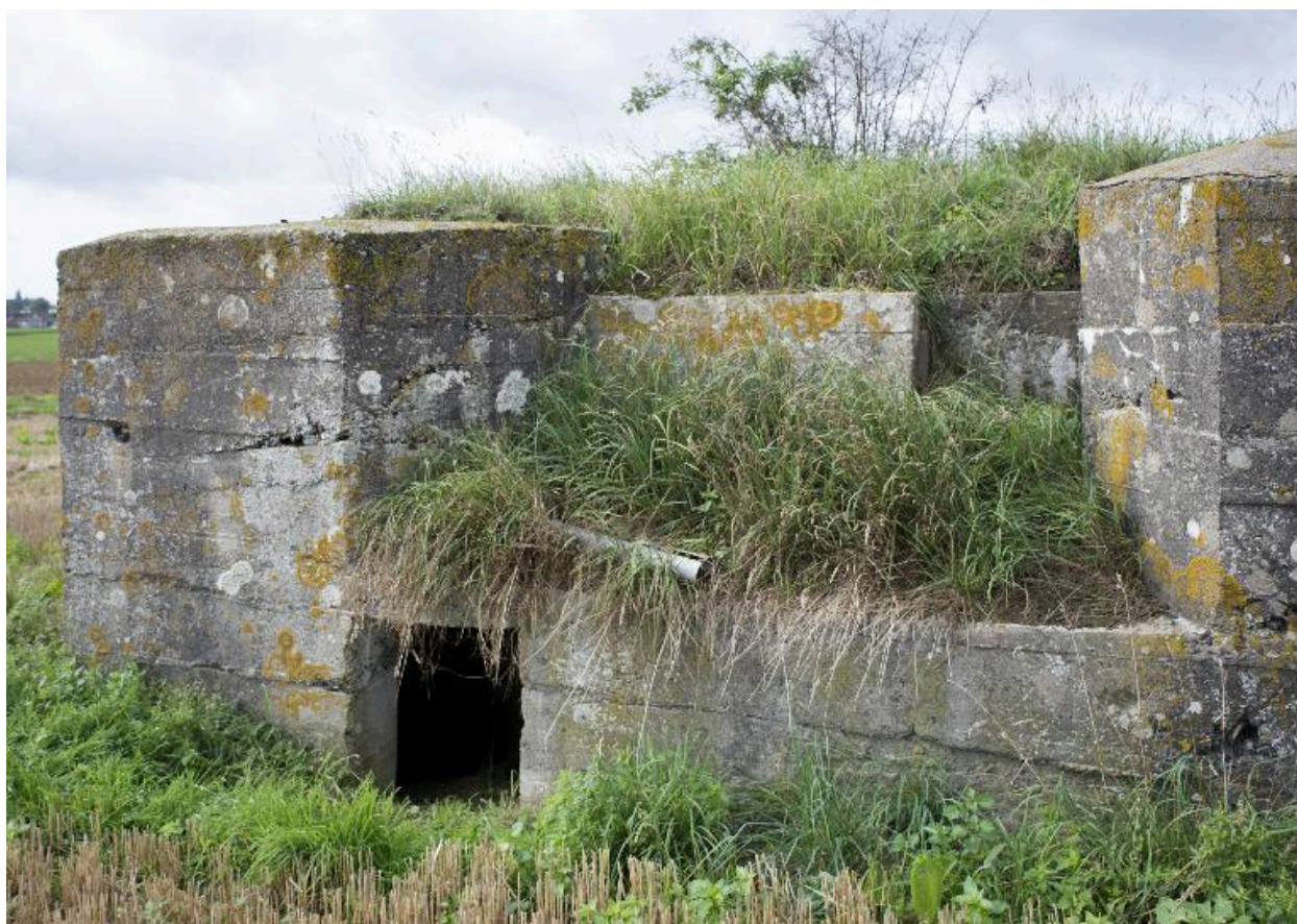
Elévation antérieure. Entrée et banquette de tir
