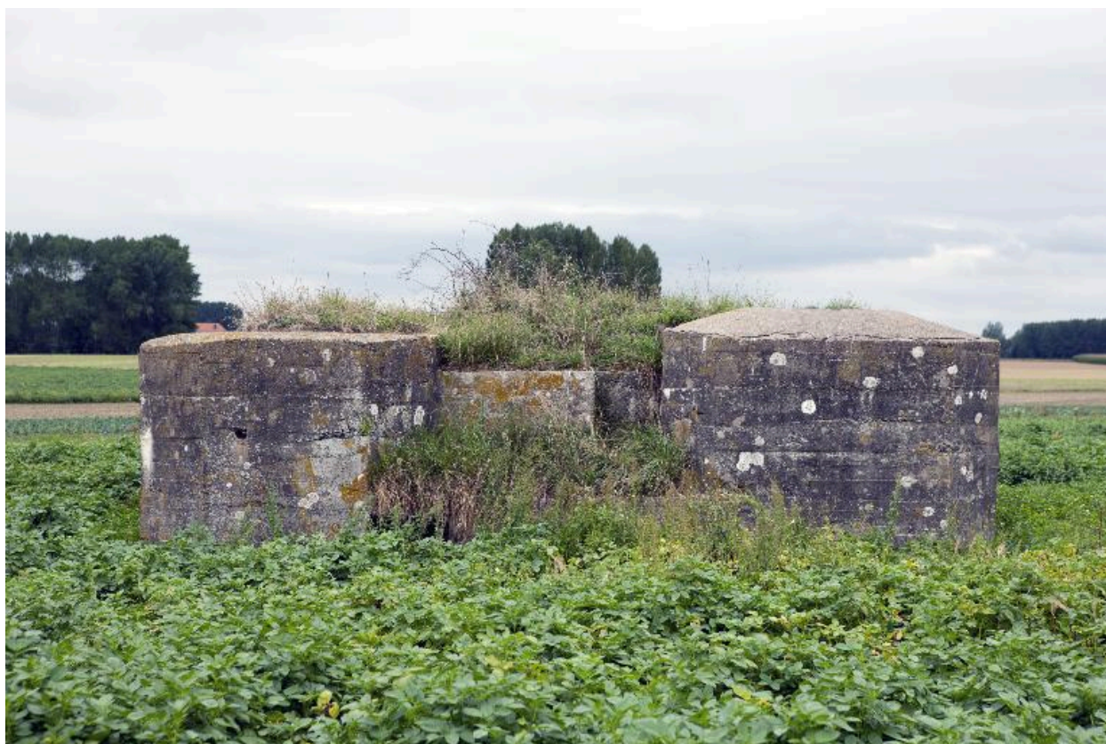
Elévation antérieure, vers l'ouest
