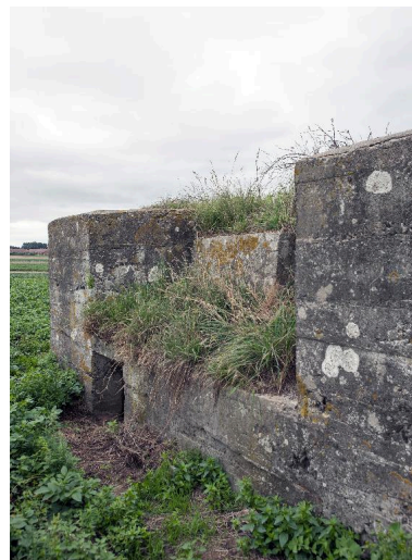
Elévation antérieure, vers le sud Phot. Pierre Thibaut IVR31_20155901442NUCA
