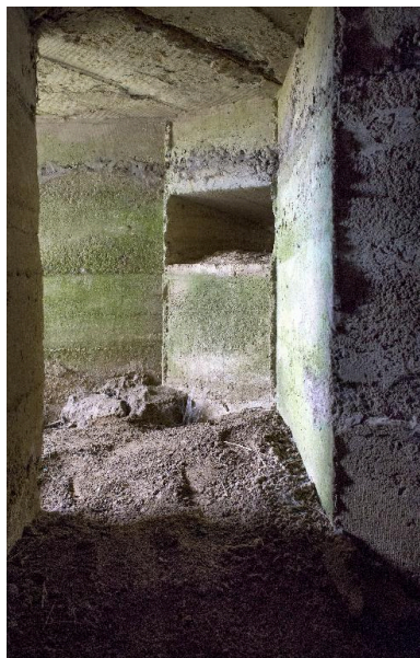
Vue intérieure de la chicane de l'entrée antérieure avec son créneau de fusillade Phot. Jean-Marc Ramette IVR32_20165901479NUCA
