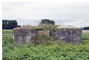
Élévation antérieure, vers l'ouest Phot. Pierre Thibaut IVR31_20155901440NUCA
