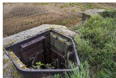
Poste d'observation cuirassé privé de son couvrement Phot. Jean-Marc Ramette IVR32_20165901475NUCA
