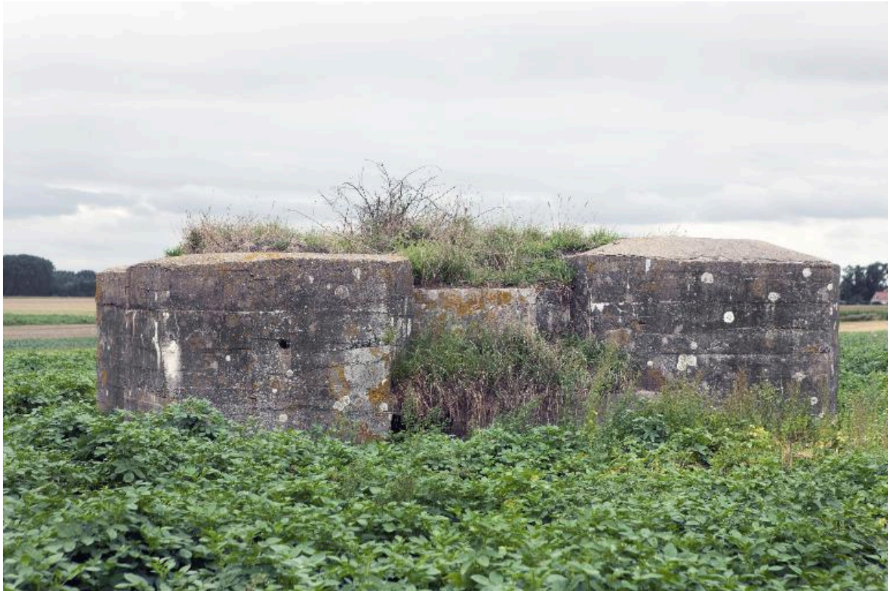
Elévation antérieure, vers l'ouest
