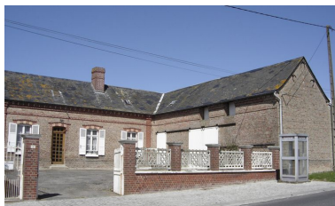
Vue de la grange. Phot. Inès Guérin IVR22_20058005550NUCA
