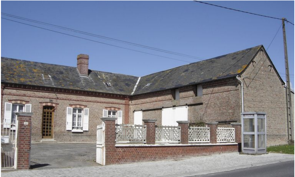
Vue de la grange.
