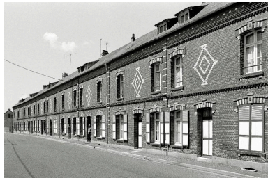
Vue générale de la cité ouvrière depuis la rue Emile-Zola, en 1990. Phot. Francis Dubuc IVR22_19908000377Z
