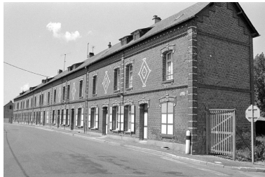
Vue générale de la cité ouvrière depuis la rue Emile-Zola, en 1990. Phot. Francis Dubuc IVR22_19908000378Z
