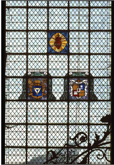
Vue de la partie ornementale de la verrière. Phot. Irwin Leullier IVR22_20030200817XA
