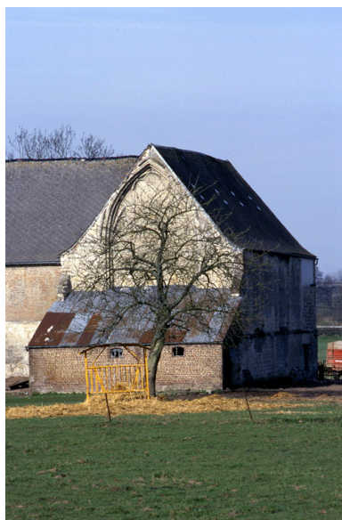
Eglise abbatiale, depuis l'est. Phot. Christiane Riboulleau IVR22_19960200471ZA
