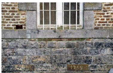
Détail de l'élévation ouest de la partie subsistante des bâtiments abbaciaux, montrant une pierre datée de 1759. Phot. Martine Plouvier IVR22_19930201336ZA
