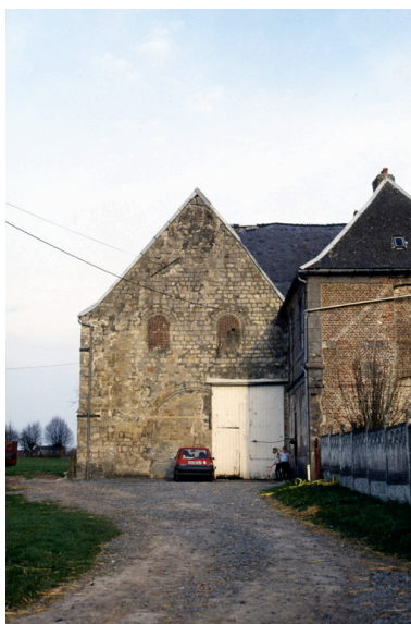
Vue de la façade de l'église abbatiale. Phot. Martine Plouvier IVR22_19930201333ZA
