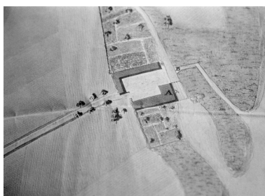
CLAIROIX. Moulin à tan Boves, puis moulin Lesguillon. Détail du plan, 1821 (AD Oise ; 7 Sp 223) Phot. Fournier Bertrand (reproduction) IVR22_20006000496ZB
