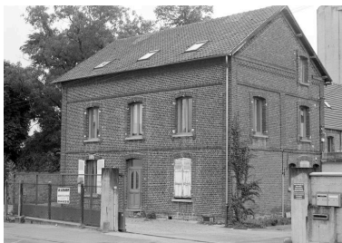
Maison de brasseur construite en 1895. Phot. Bertrand Fournier IVR22_19996001425Z
