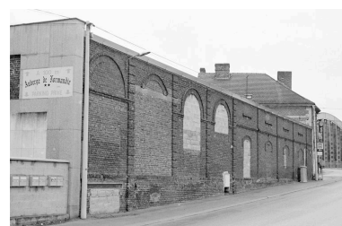
Atelier de fabrication, façade sur rue. Phot. Bertrand Fournier IVR22_19996001426Z
