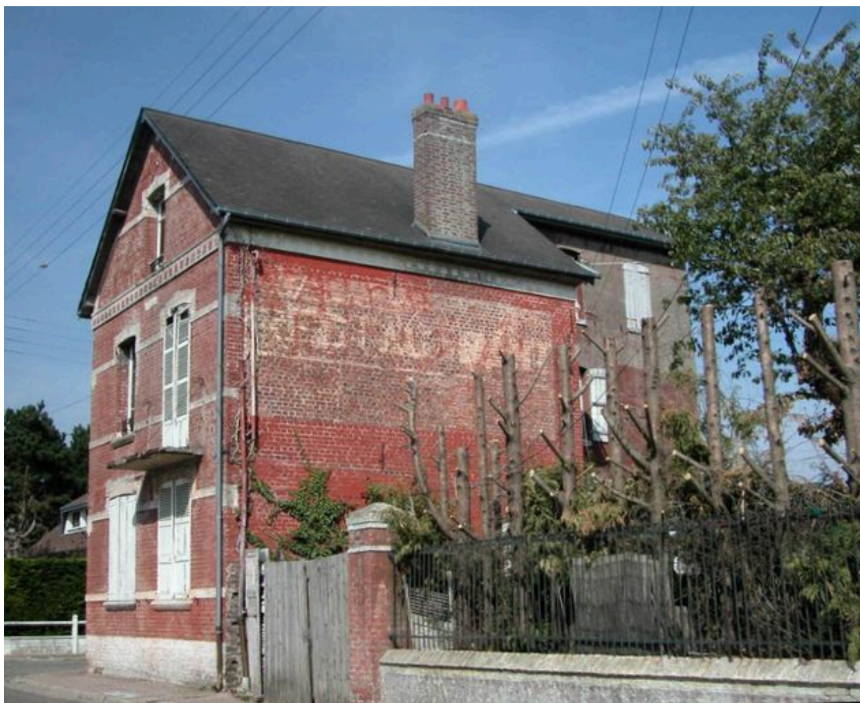
Elévation latérale droite et façade postérieure avec extension, vue depuis la rue Vadicocq.
