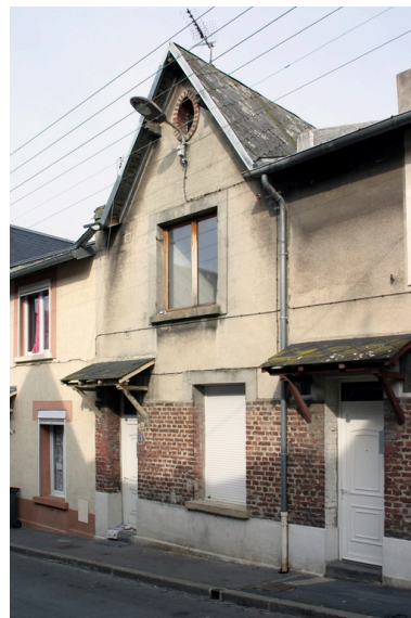
Façade antérieure d'un logement à lucarne. Phot. Frédéric Pillet IVR22_20060205096NUCA
