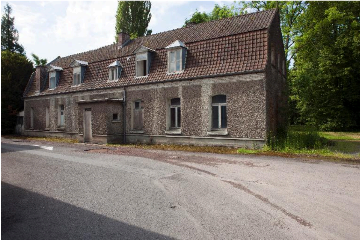
Vue générale de l'ancien hôpital des pauvres, appelé Villa Romaine au début du 20e siècle, élévation antérieure (?), construit en 1780.
