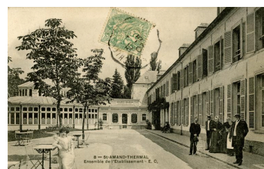
Vue générale du grand hôtel et de la rotonde des bains, carte postale (Médiathèque Saint-Amand-les-Eaux). IVR31_20155908001NUCA
