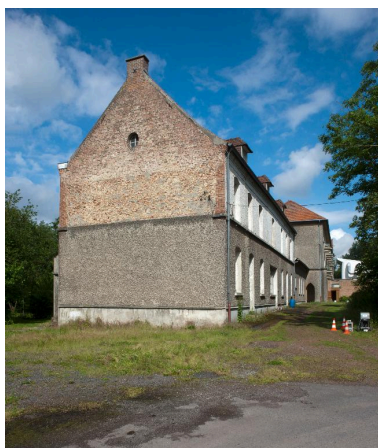
Depuis l'est, en alignement, l'ancien hôpital militaire, réhabilité et intégré dans le projet de Grand Hôtel dans les années 1920. Phot. Pierre Thibaut IVR31_20125901805NUCA
