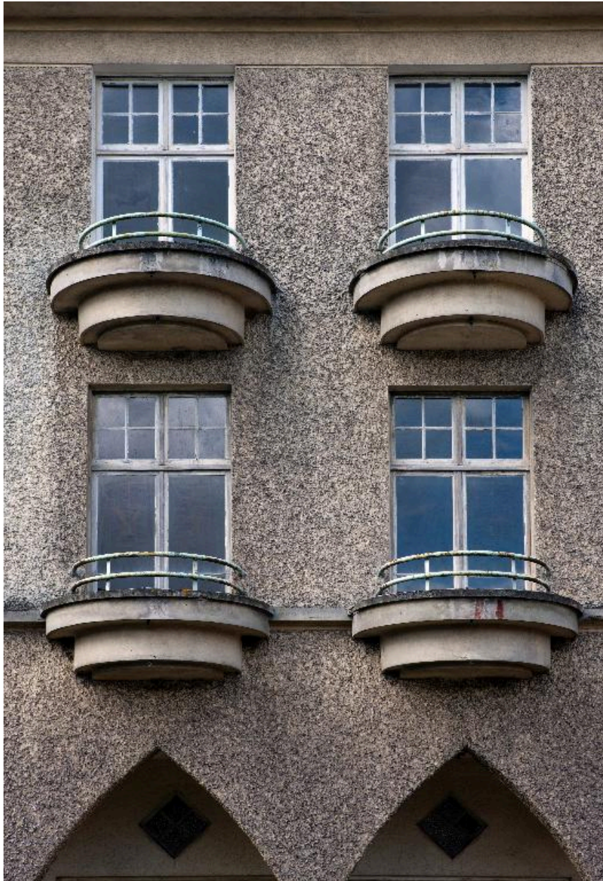
Ancien hôpital militaire réhabilité dans le projet de Grand Hôtel ; détail de l'élévation postérieure.
