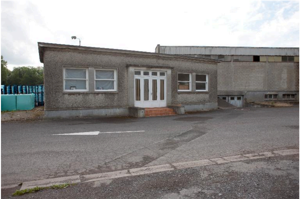
Bureaux de l'usine de mise en bouteilles des eaux minérales.
