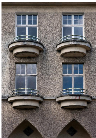
Ancien hôpital militaire réhabilité dans le projet de Grand Hôtel ; détail de l'élévation postérieure.
