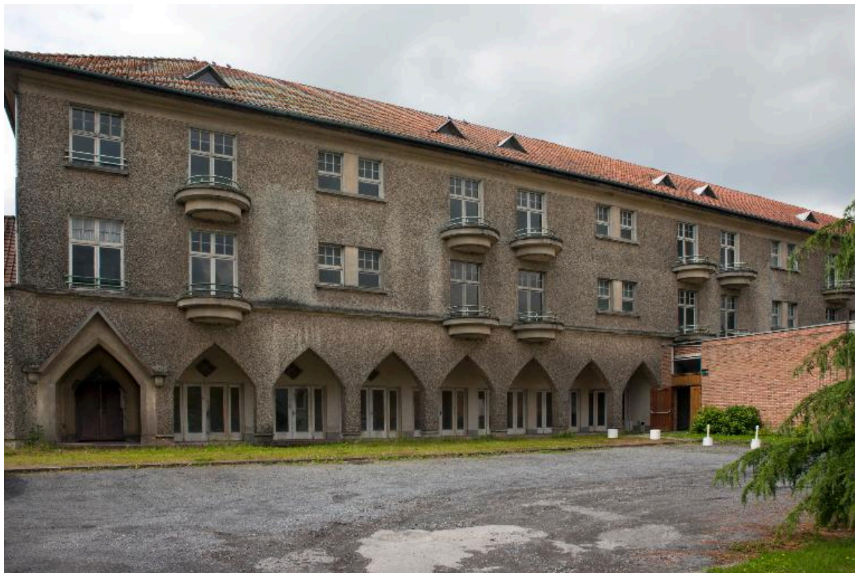
Vue générale de l'ancien hôpital militaire réhabilité dans le projet de Grand Hôtel, élévation postérieure.
