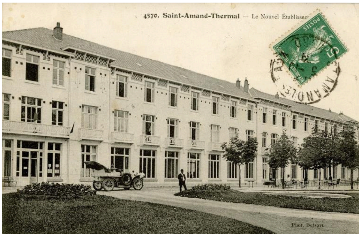
Vue générale, depuis la cour, du grand hôtel reconstruit après 1907, carte postale (Médiathèque Saint-Amand-les-Eaux).
