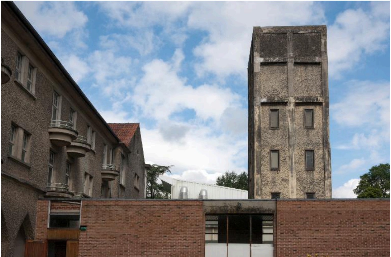
Vue générale de l'ancien hôpital militaire réhabilité dans le projet de Grand Hôtel et château d'eau.
