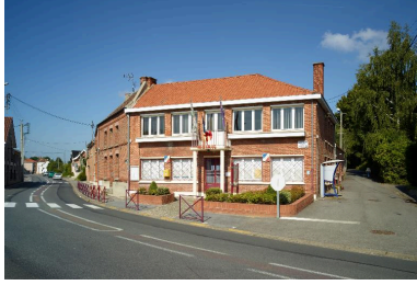
Vue générale. Phot. Pierre Thibaut IVR31_20155901590NUCA
