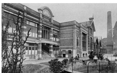
Cour de l'usine après restauration, vers 1921 (Le Monde Illustré). Phot. Pillet Frédéric IVR22_20060205657NUCAB
