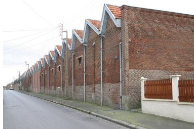
Les ateliers à l'angle de la rue Thiers et de l'impasse Sainte-Marguerite. Phot. Frédéric Pillet IVR22_20070205145NUCA
