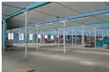
Vue intérieure des ateliers de 1911. Phot. Frédéric Pillet IVR22_20070205149NUCA
