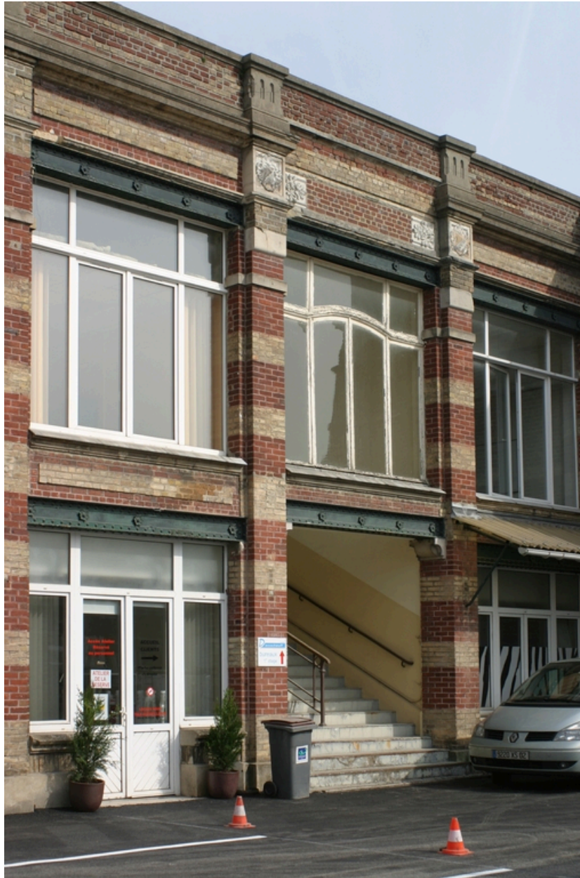
Façade des bureaux construits en 1913.
