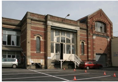
Salles des machines des années 1870 (à droite) et de 1913 (à gauche). Phot. Frédéric Pillet IVR22_20070205142NUCA
