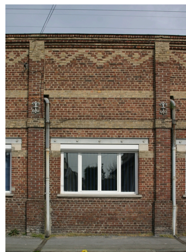
Détail d'une travée de l'atelier de broderie de 1912. Phot. Frédéric Pillet IVR22_20070205141NUCA
