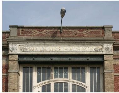
Salle de machines de 1913, détail. Phot. Frédéric Pillet IVR22_20070205143NUCA
