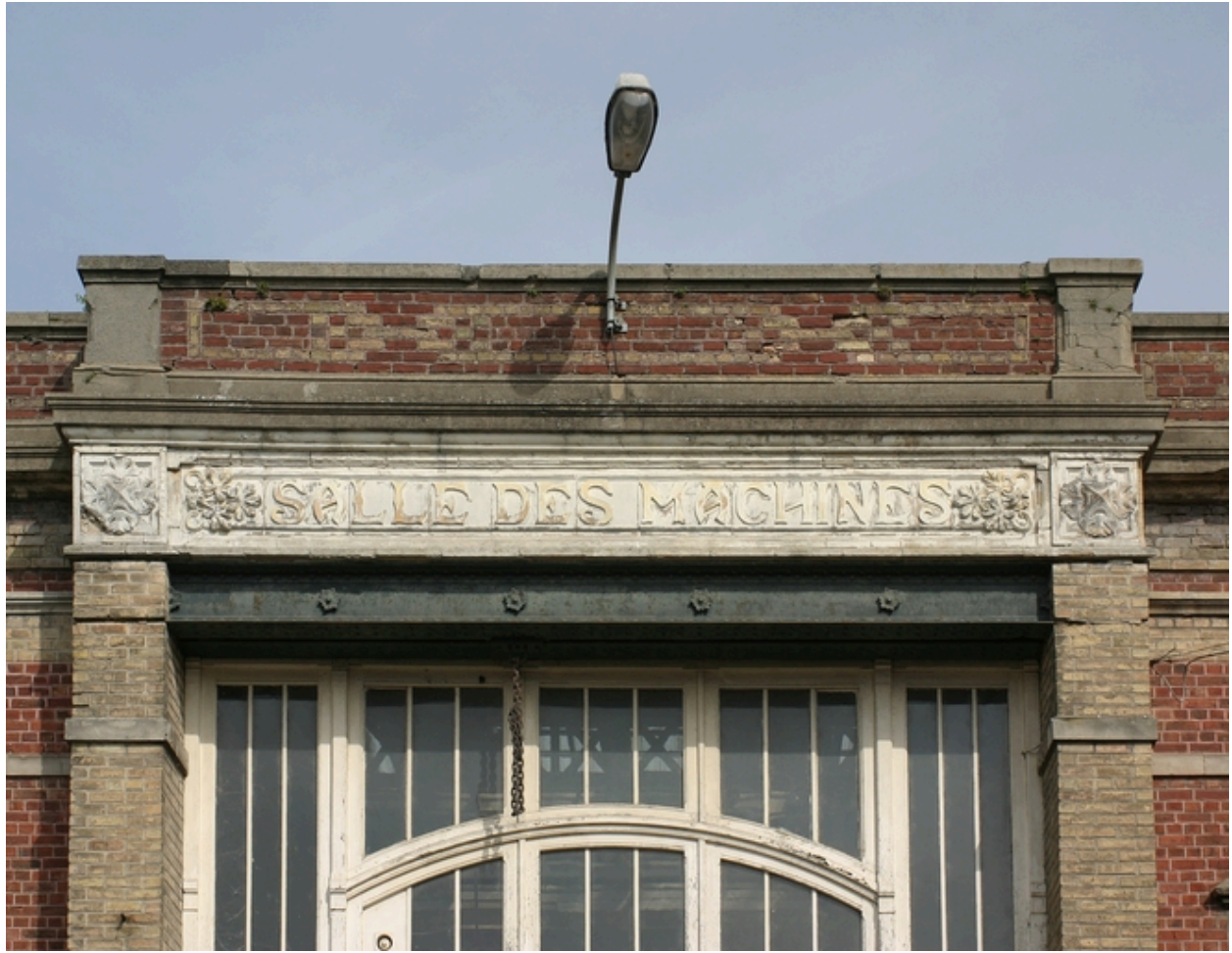
Salle de machines de 1913, détail.
