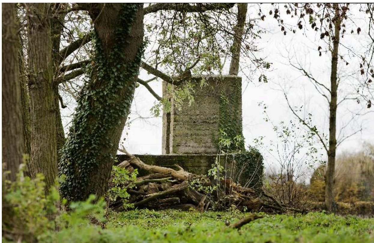
Vue partielle, vers le sud-ouest
