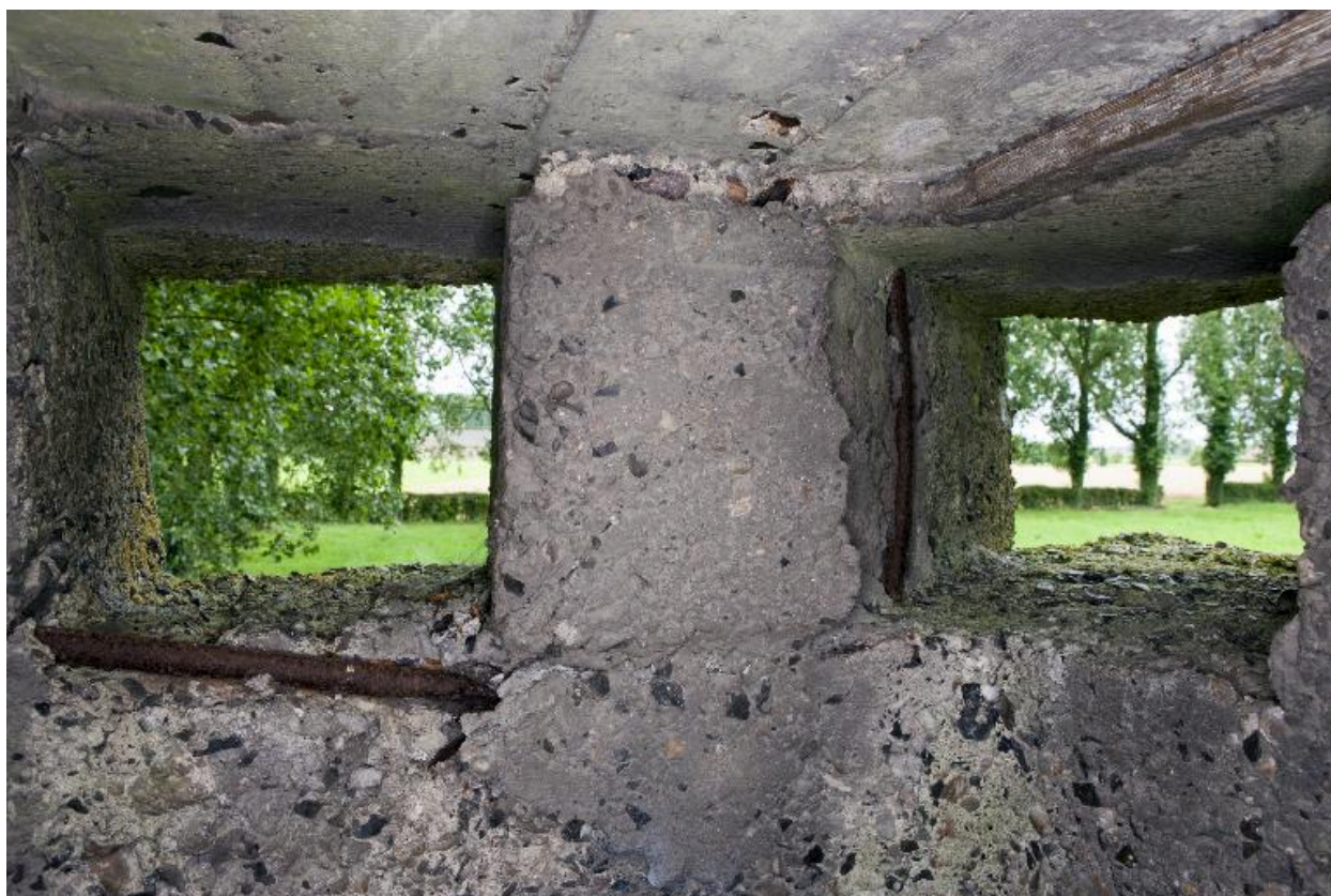
Tourelle d'observation ou de communication optique, vue intérieure
