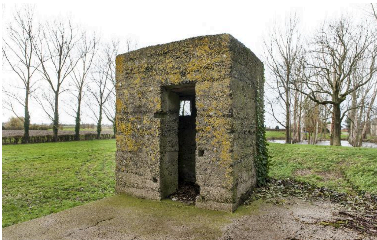
Tourelle d'observation ou de communication optique vers l'ouest
