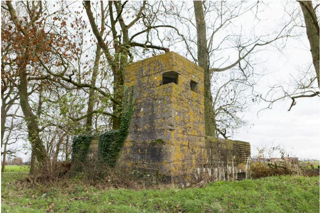
Vue d'ensemble vers l'est
