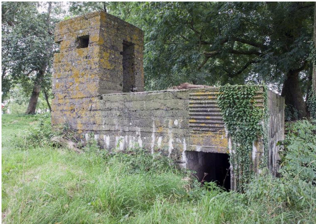
Vue latérale, vers le nord. Tourelle d'observation ou de communication optique et accès sud-ouest au couloir de distribution
