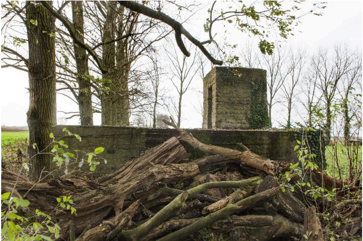
Vue latérale vers le sud-ouest
