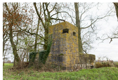
Vue d'ensemble vers l'est Phot. Jean-Marc Ramette IVR31_20145904639NUCA
