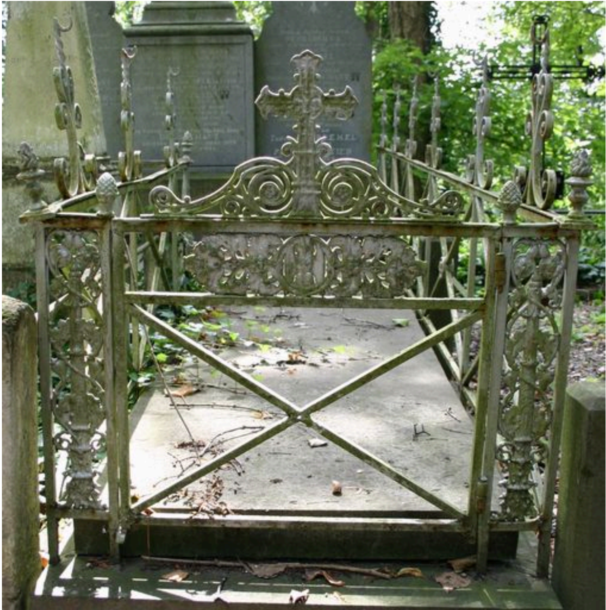
Portillon de clôture.
