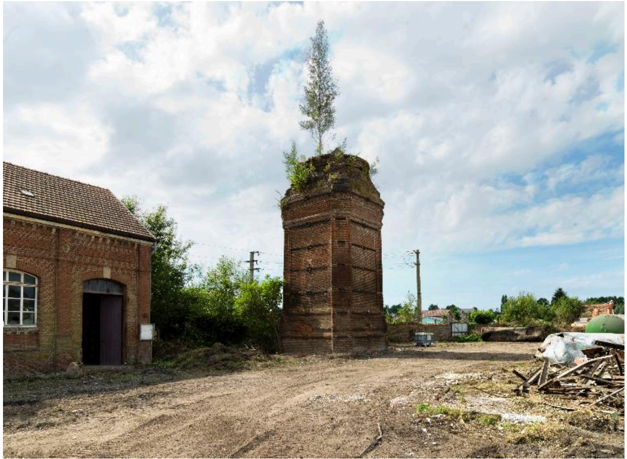
Vestiges de la cheminée de l'usine, juillet 2012.
