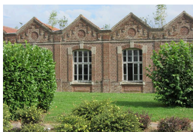
Façade sur rue des bâtiments administratifs, vue partielle. Phot. Bertrand Fournier IVR22_20128005341NUC2A
