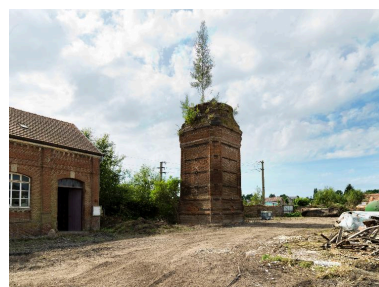
Vestiges de la cheminée de l'usine, juillet 2012. Phot. Thierry Lefébure IVR22_20128000557NUC2A
