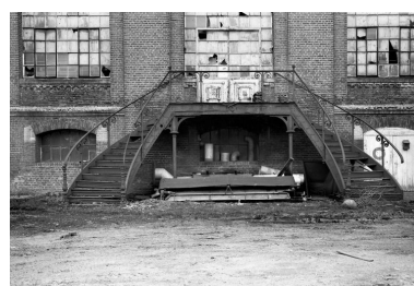
Escalier extérieur de la salle des machines, en 1988. Phot. Thierry Lefébure IVR22_19888000469X
