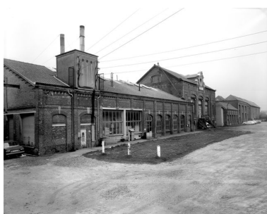
Chaufferie, salle des machines (bâtiments 2a et 7), en 1988 : élévation sud-ouest. Phot. Thierry Lefébure IVR22_19888000464V
