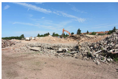
Les ateliers de tissage en cours de démolition, état juillet 2012. Phot. Bertrand Fournier IVR22_20128005343NUC2A
