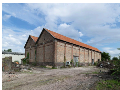
Vue d'ensemble des entrepôts avant destruction, juillet 2012. Phot. Thierry Lefébure IVR22_20128000559NUC2A
