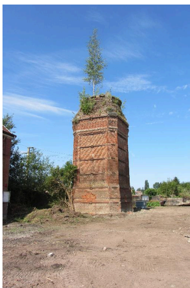
La base de la cheminée d'usine avant sa démolition, juillet 2012. Phot. Bertrand Fournier IVR22_20128005342NUC2A
