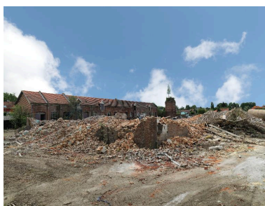
Vue d'ensemble des ateliers en cours de destruction, juillet 2012. Phot. Thierry Lefébure IVR22_20128000556NUC2A
