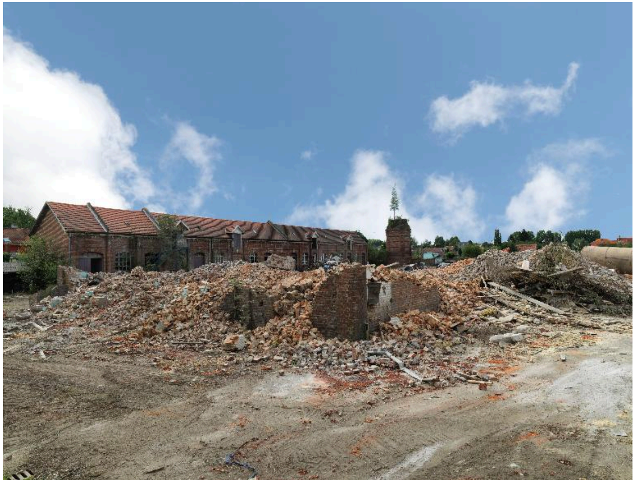
Vue d'ensemble des ateliers en cours de destruction, juillet 2012.
