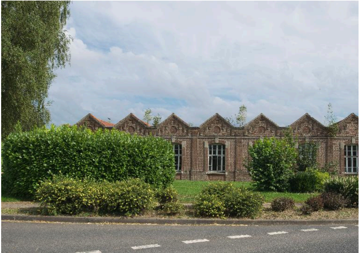
Façade sur rue des bâtiments administratifs, vue partielle.
