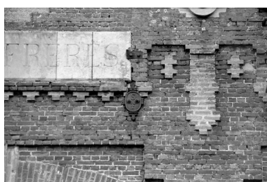
Détail de la façade de la salle des machines, en 1988. Phot. Thierry Lefébure IVR22_19888000489Z
