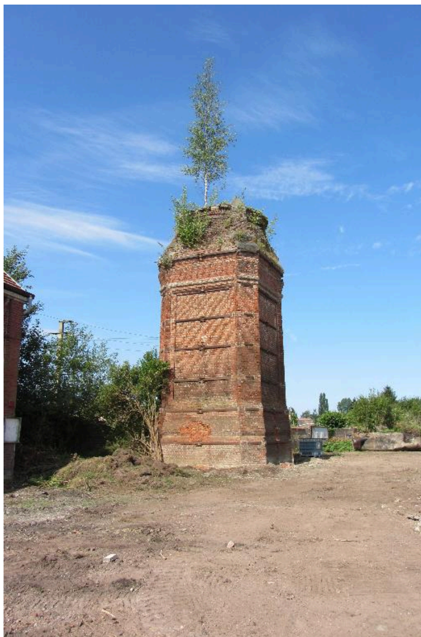
La base de la cheminée d'usine avant sa démolition, juillet 2012.
