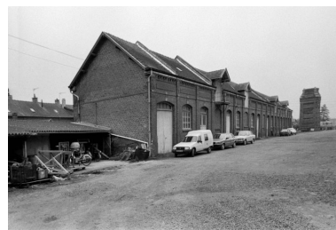
Magasin des pièces détachées, façade sur cour, en 1988. Phot. Thierry Lefébure IVR22_19888000500Z
