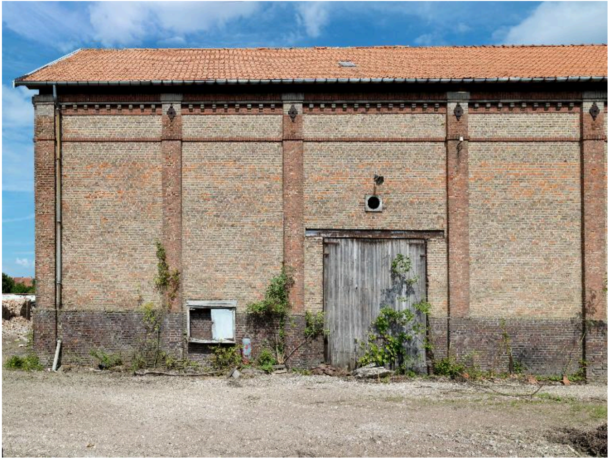
Elévation longitudinale partielle des entrepôts, juillet 2012.
