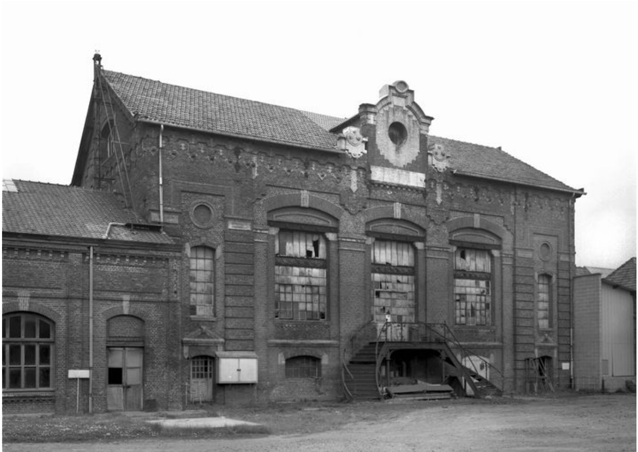
Salle des machines (bâtiment 7), en 1988 : élévation antérieure.
