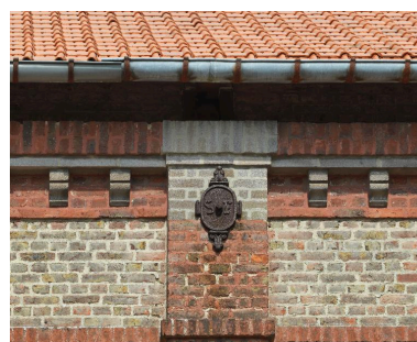
Détail d'un fer d'ancrage des entrepôts de l'usine portant les initiales SF. Phot. Thierry Lefébure IVR22_20128000561NUC2A
