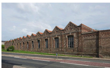
Vue d'ensemble de la façade sur rue des bâtiments administratifs de l'usine. Phot. Thierry Lefébure IVR22_20128000555NUC2A
