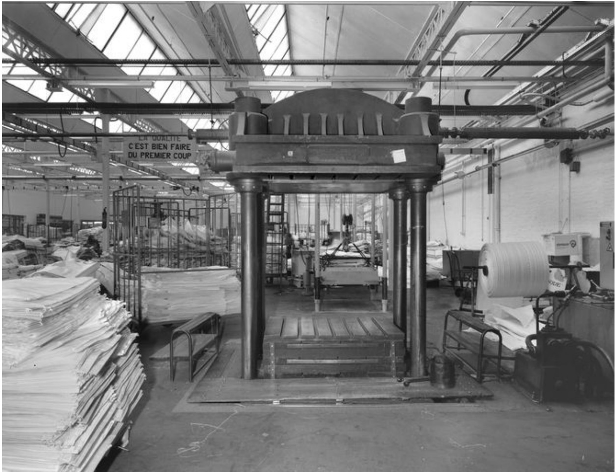
Intérieur de l'atelier de fabrication, abritant une presse hydraulique de 1899, état de 1988.
