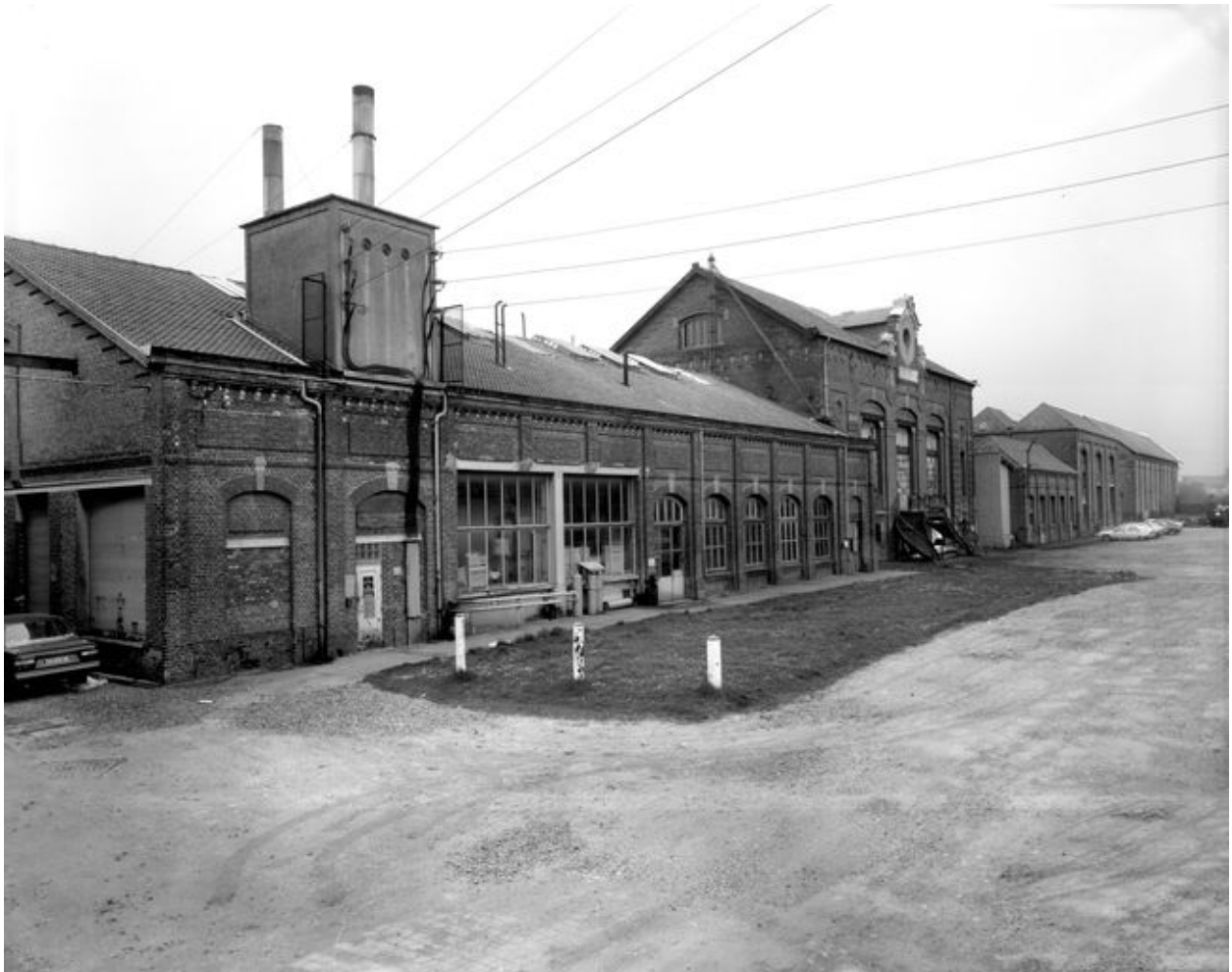
Chaufferie, salle des machines (bâtiments 2a et 7), en 1988 : élévation sud-ouest.
