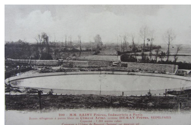
L'ancien bassin réfrigérant situé à l'arrière de l'usine, vers 1920 (coll. part.). Phot. Fournier Bertrand (reproduction) IVR22_20138015663NUC2A
