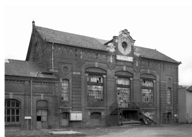
Salle des machines (bâtiment 7), en 1988 : élévation antérieure. Phot. Thierry Lefébure IVR22_19888000467X
