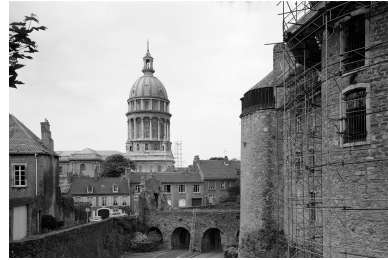
Environnement rue de Bernet, rue du Château. Phot. Jean-Michel Périn, Phot. Éric Dessert IVR31_19806202989X
