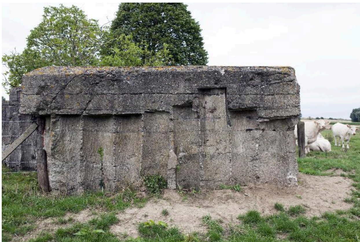
Partie sud de l'édifice, vers le nord
