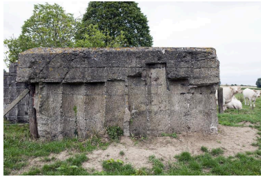
Partie sud de l'édifice, vers le nord Phot. Pierre Thibaut IVR31_20155901462NUCA
