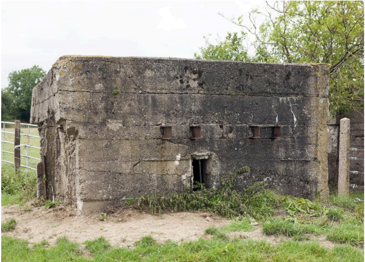
Partie sud de l'édifice, vers le nord-ouest
