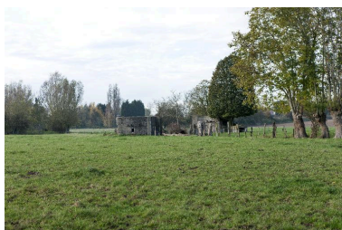
Vue le nord-ouest, depuis le chemin de l'Aventure Phot. Jean-Marc Ramette IVR31_20145904879NUCA
