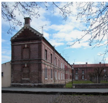
Vue d'ensemble du corps de bâtiment ouest. Phot. Bertrand Fournier IVR22_20046002854NUCA
