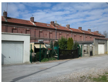
Corps de bâtiment nord, façade postérieure. Phot. Bertrand Fournier IVR22_20046002855NUCA
