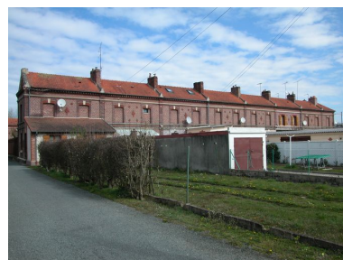
Corps de bâtiment est, façade postérieure. Phot. Bertrand Fournier IVR22_20046002856NUCA
