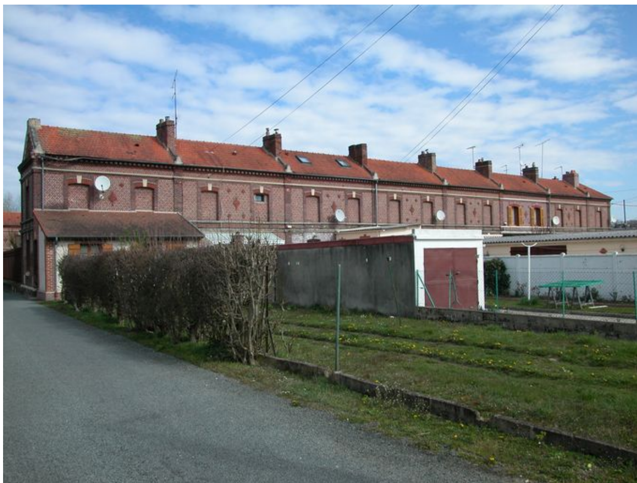
Corps de bâtiment est, façade postérieure.
