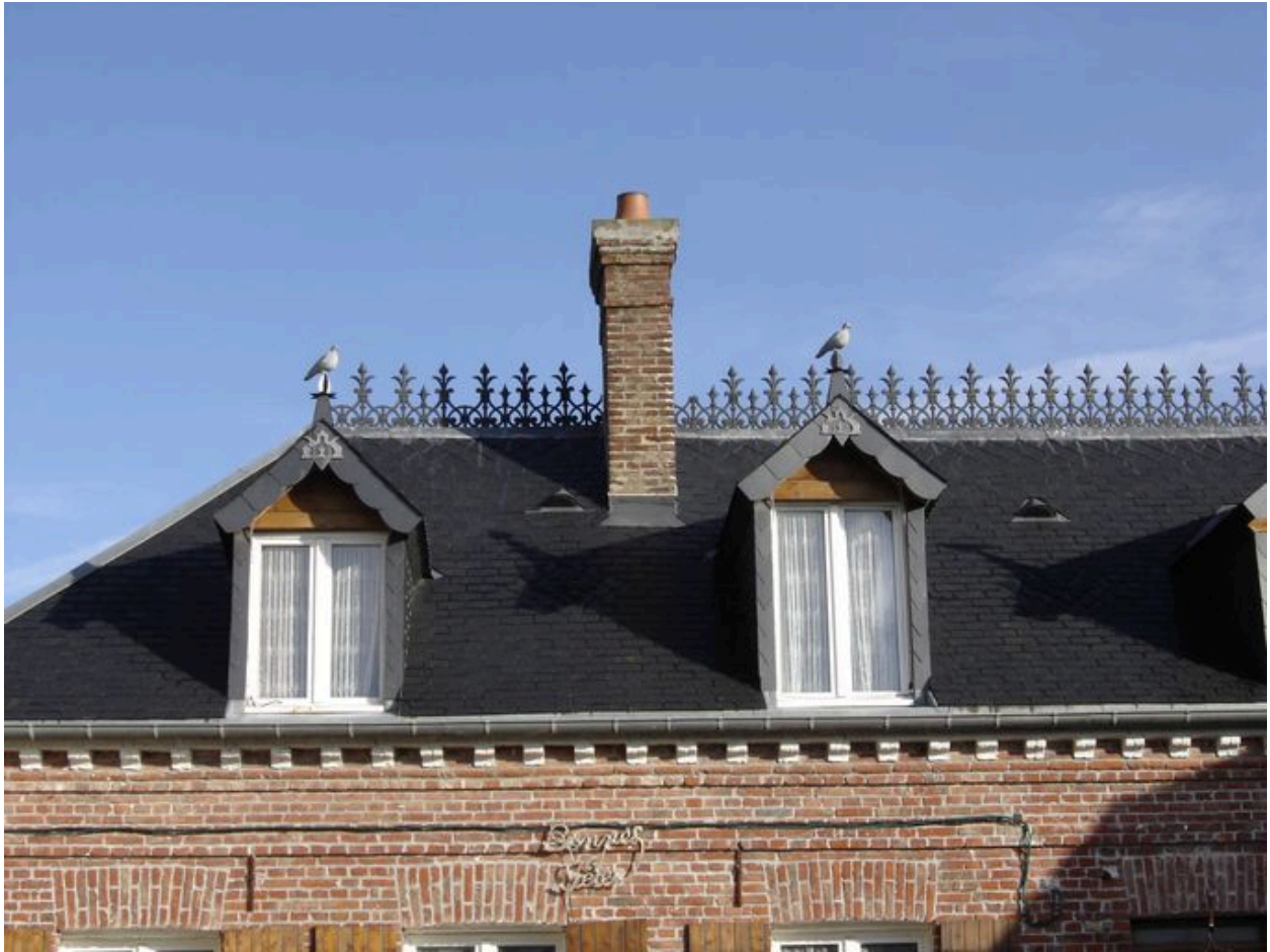
Vue détaillée de la crête en zinc.
