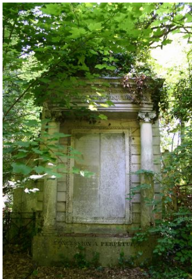
Stèle architecturée, vers 1851. Phot. Caroline Vincent IVR22_20098001197NUCA
