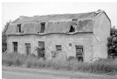
Maison, 334 route Nationale. Phot. Jean-Michel Périn IVR22_19856000783X
