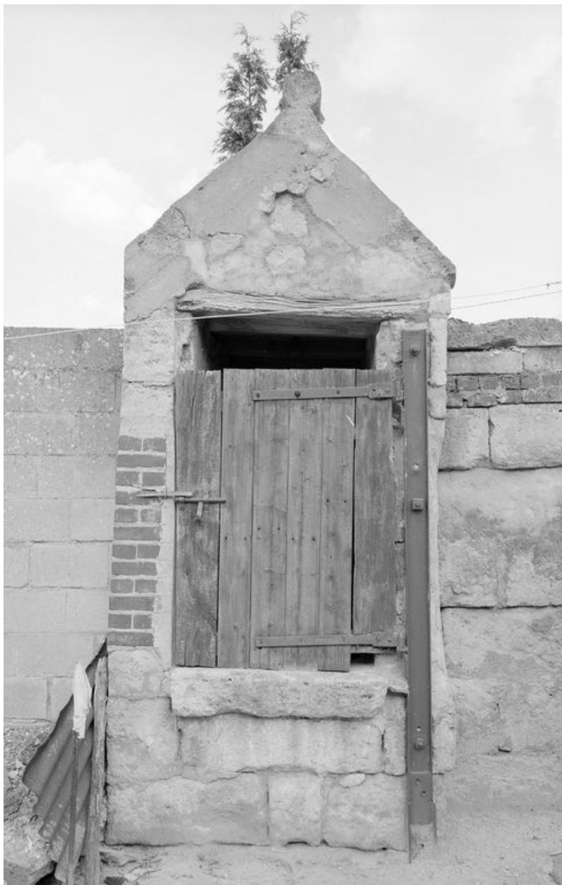
Puits d'une ferme repérée (section B4 1098).
