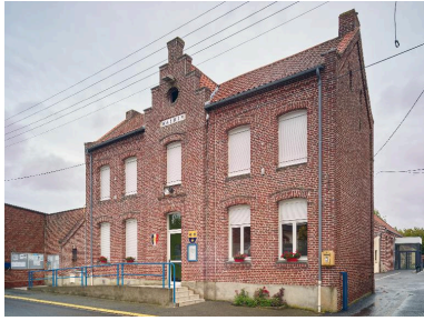
Vue générale. Phot. Pierre Thibaut IVR31_20155901624NUCA
