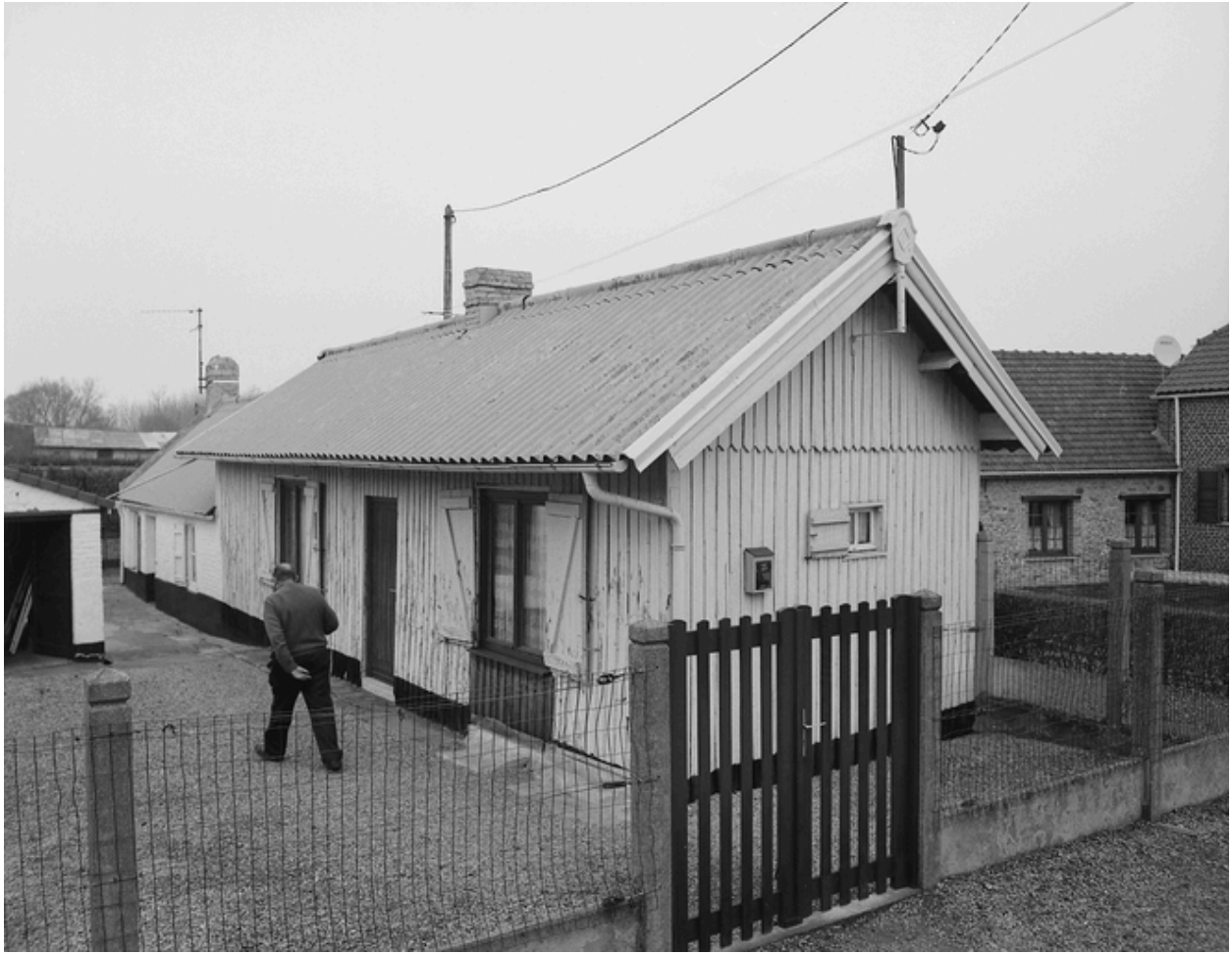
Vue générale de la maison en bois.
