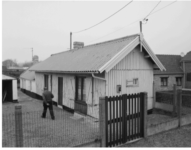
Vue générale de la maison en bois.
