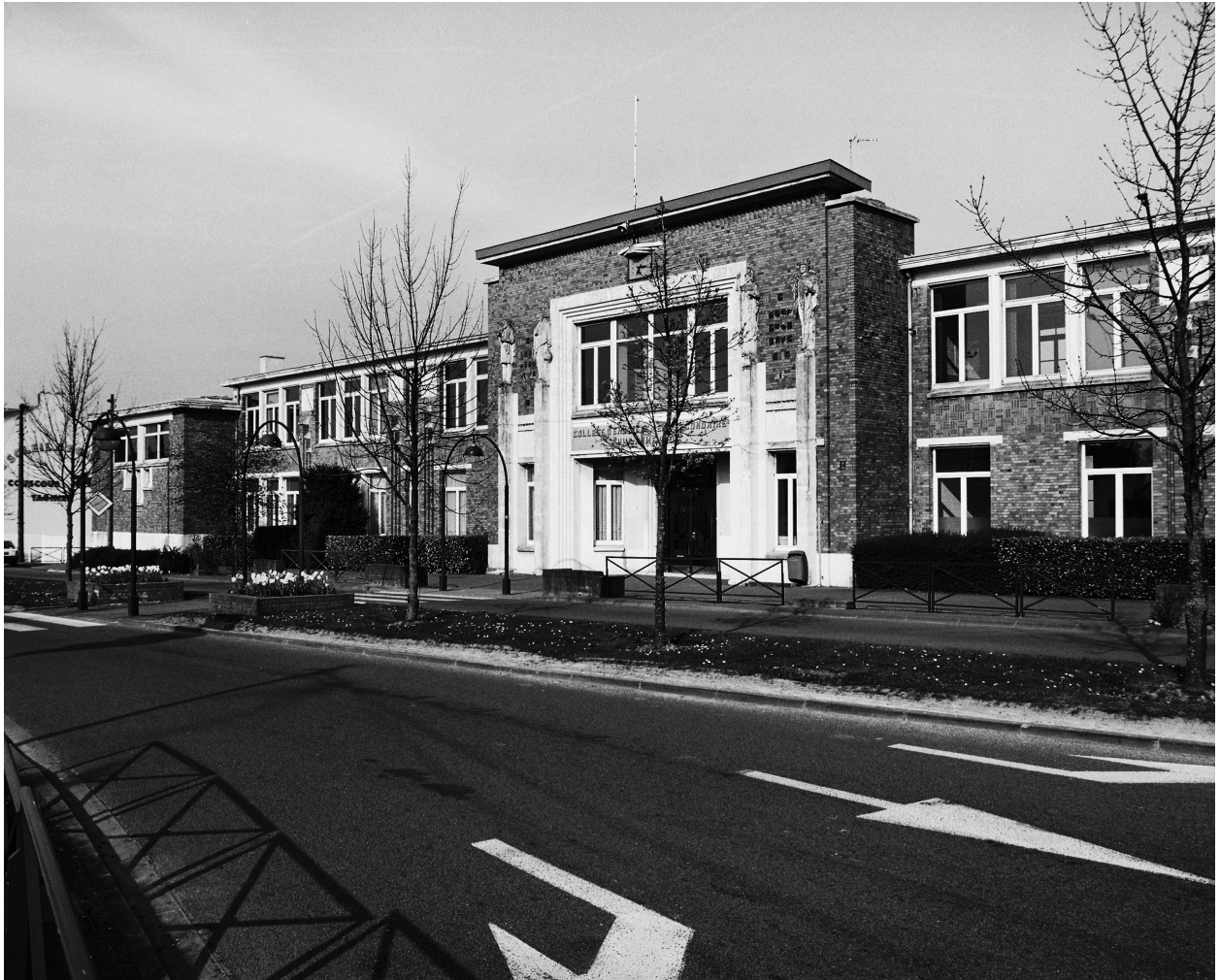
Vue partielle de l'élévation antérieure. L'entrée.
