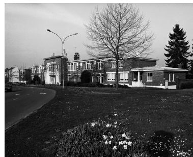
Vue générale depuis le carrefour. Phot. Thierry Petitberghien IVR31_20025901199X
