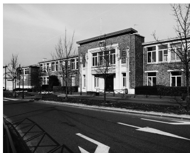
Vue partielle de l'élévation antérieure. L'entrée. Phot. Thierry Petitberghien IVR31_20025901200X
