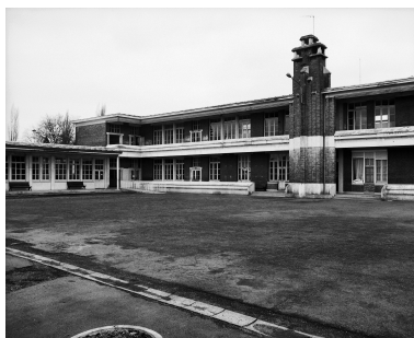
Élévation postérieure partielle. Phot. Thierry Petitberghien IVR31_20025900371X
