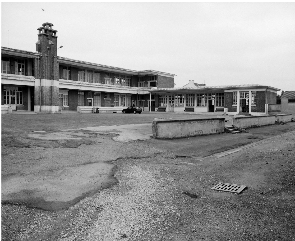
Élévation postérieure partielle et la cour.
